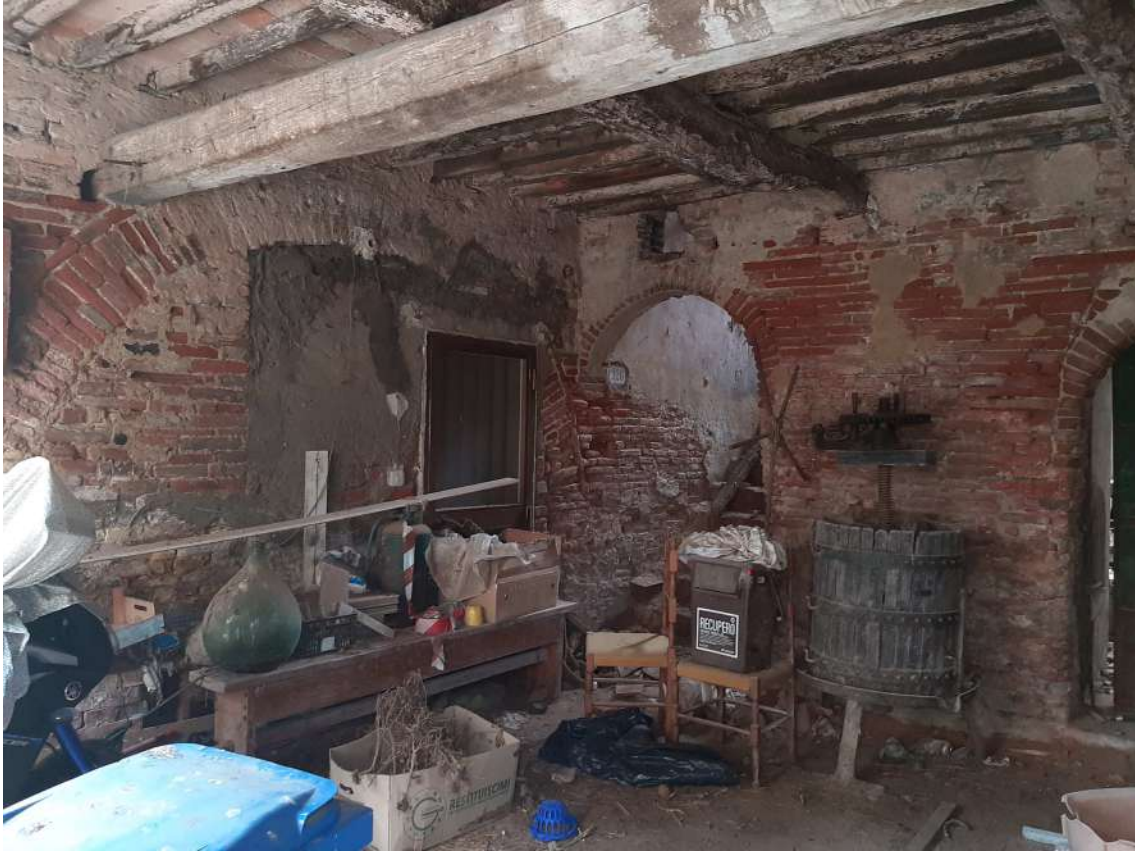
15 – Porticato esterno a comune, al piano terreno
