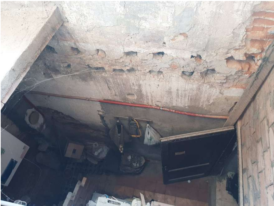
12 – affaccio della terza camera sul doppio volume del locale caldaia
