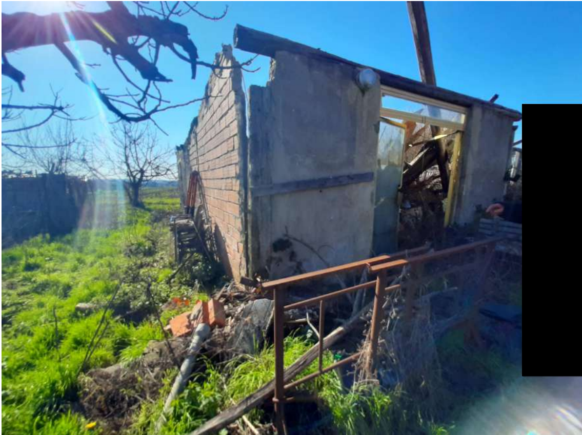
4 – Particolare della struttura.
