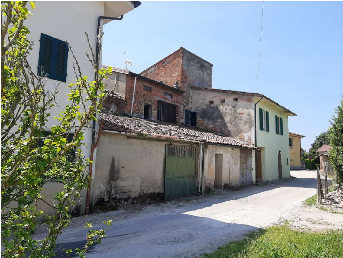
1 – L'edificio lungo via Ginevra
