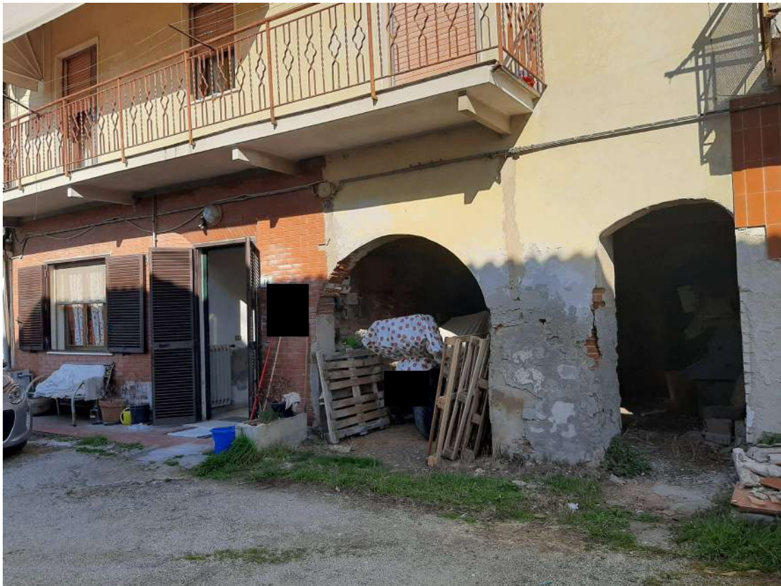
4 - Particolare della facciata interna
