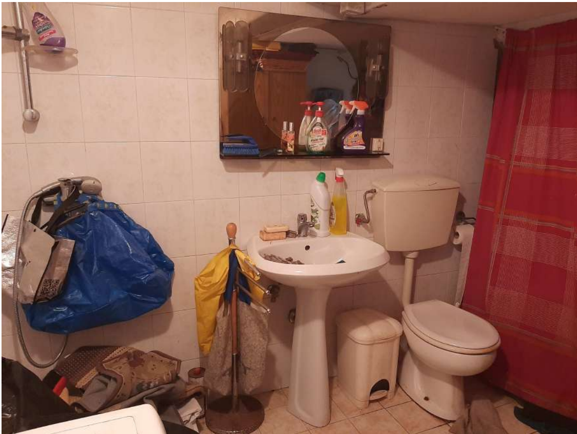
8 - Bagno al piano terreno
