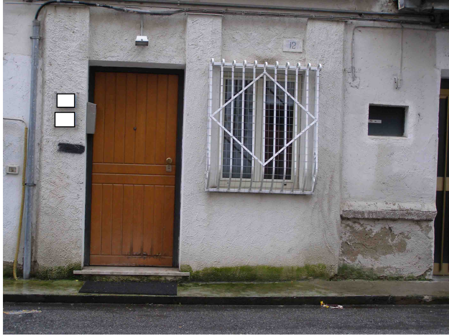
FOTO N° 1 : Ingresso unità immobiliare ad uso Ufficio sito nel Comune di Cosenza alla Via Giosuè Crucci n° 12/B ed identificato nel N.C.E.U al Foglio n° 23, part. n° 115 , sub n° 1, di superficie commerciale pari a mq. 300,00
