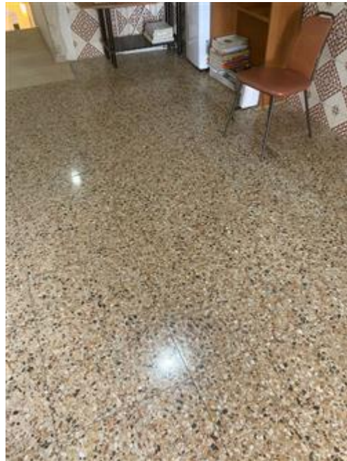
Piano Primo - disimpegno -vano scala
