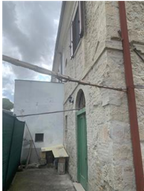
Fabbricato uso abitazione - foto esterno 4
