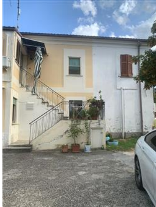
Fabbricato uso abitazione - foto esterno 2
