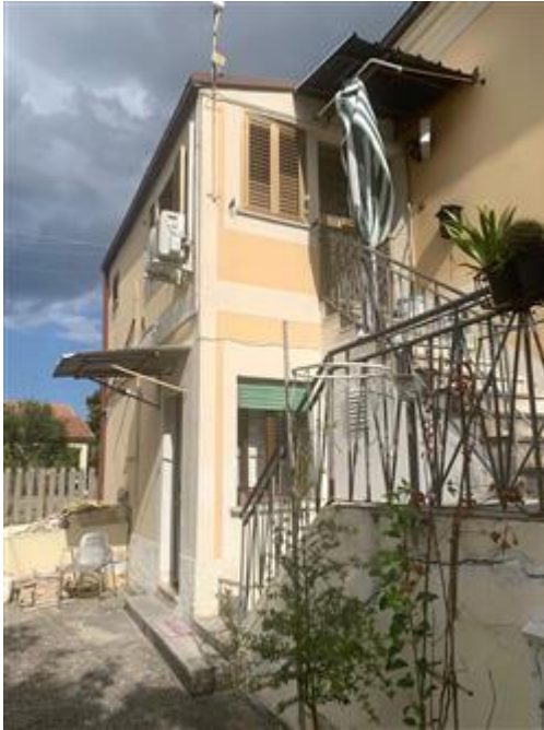
Fabbricato uso abitazione - foto esterno 1
