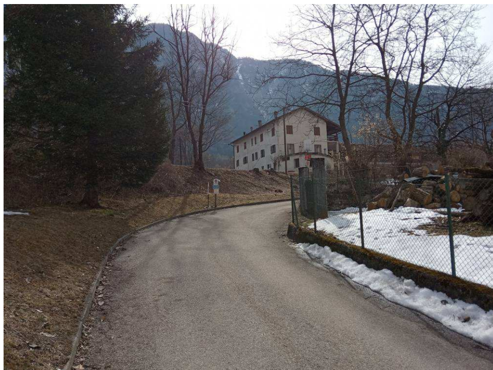
P.ed. 1670 C.C. Roncegno: strada di accesso all'edificio
