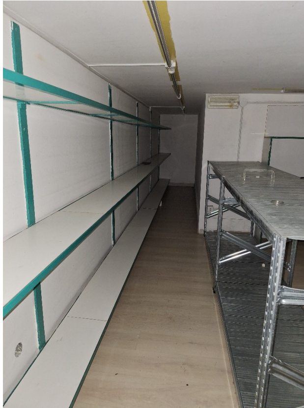
Foto 7 – Vista interna – Piano Soppalco
