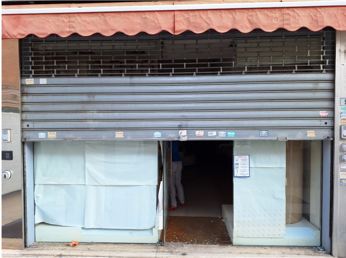
Foto 1 – Vista esterna - Ingresso
