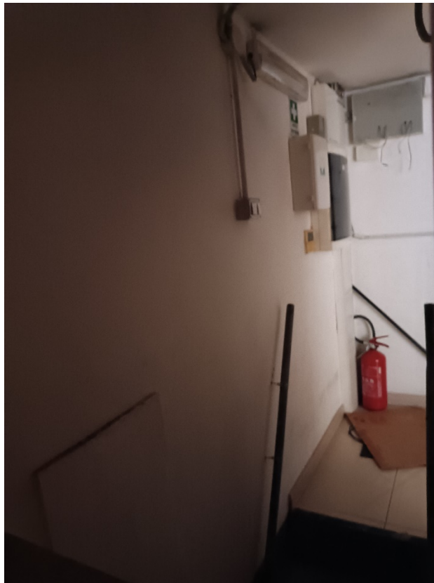
Foto 4 – Vista interna – Piano Terra
