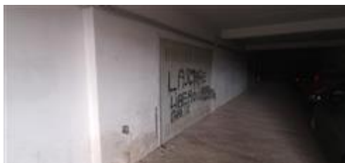
PORTA D'INGRESSO AI LOCALI MAGAZZINO
