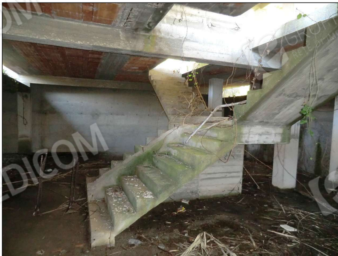
Foto 10_piano interrato lato nord
