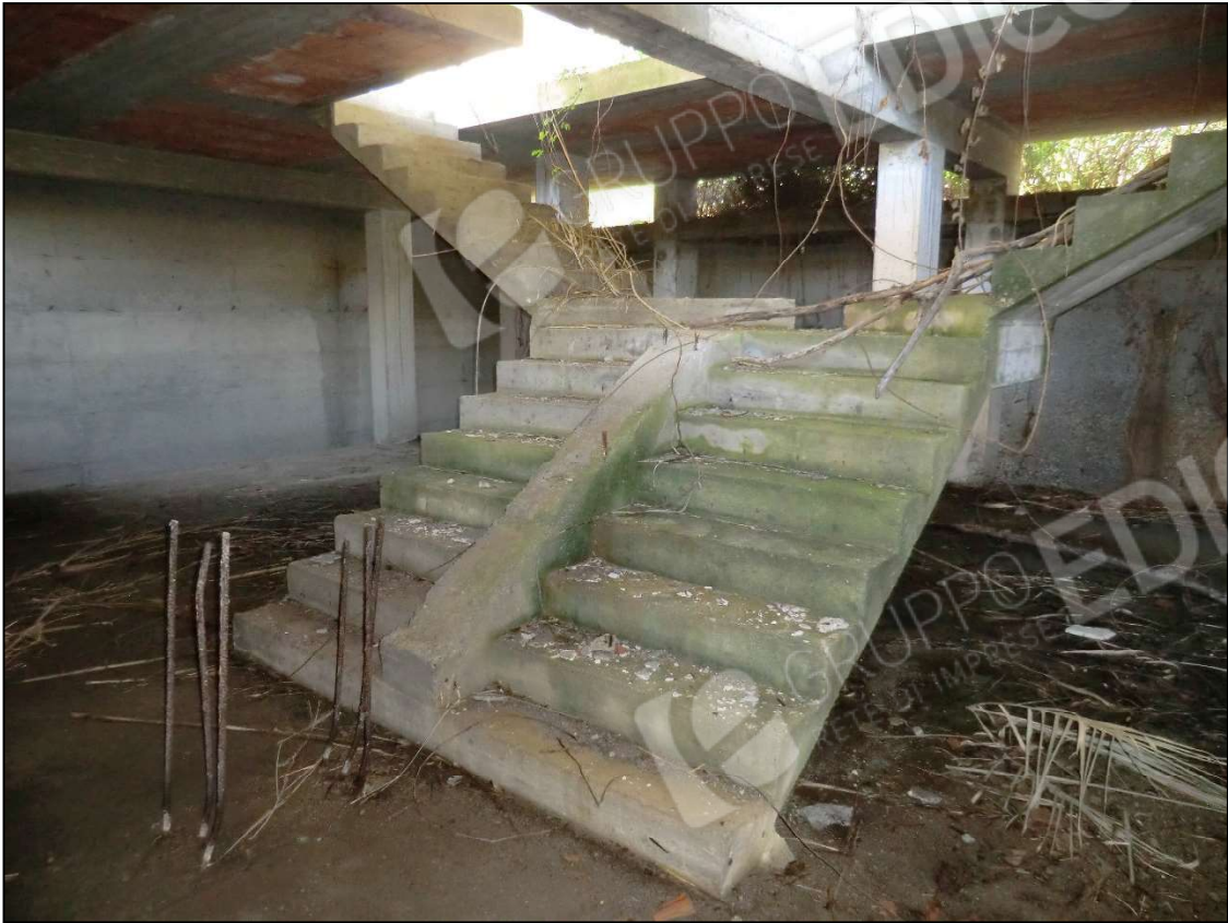
Foto 11_piano interrato lato nord
