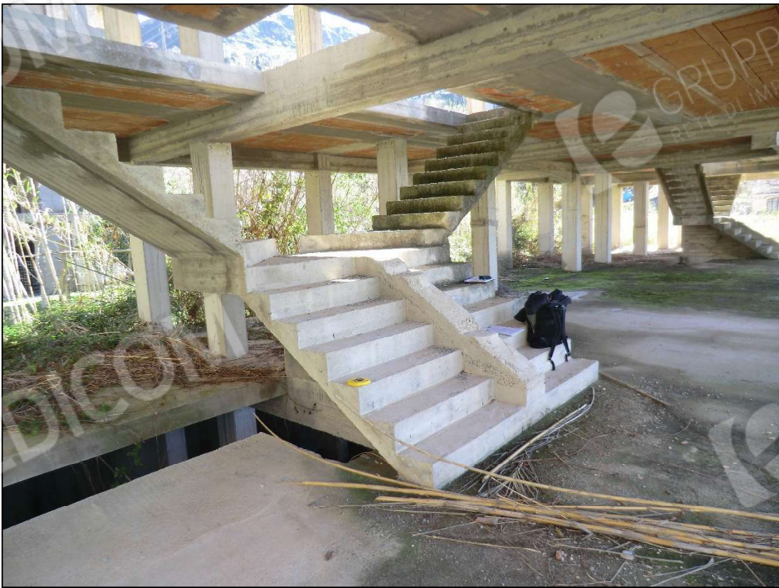
Foto 14_piano terra vista verso sud
