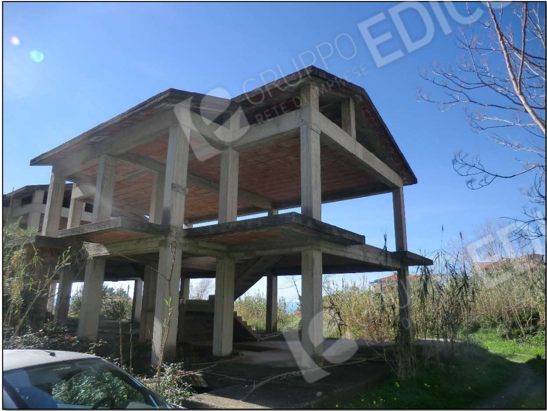
Foto 5_vista nord est
