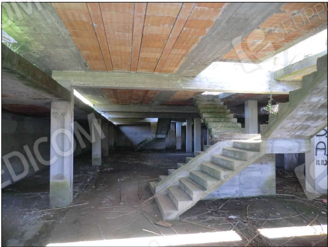
Foto 12_piano interrato vista verso nord
