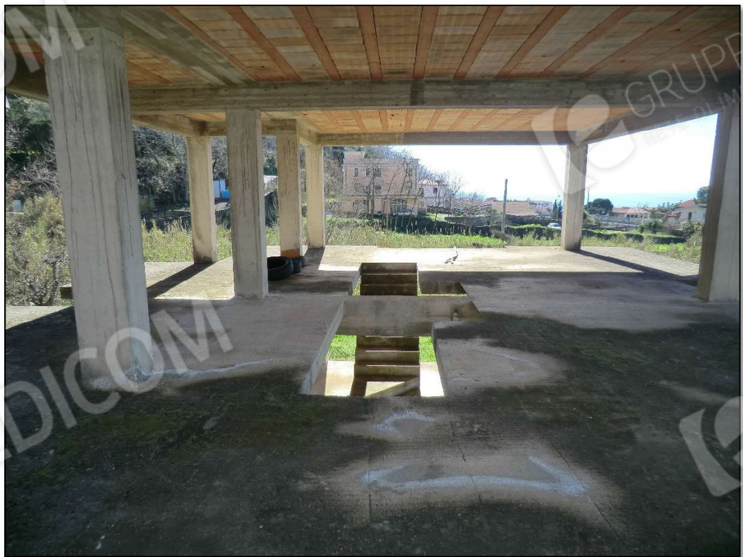
Foto 16_piano primo vista verso sud
