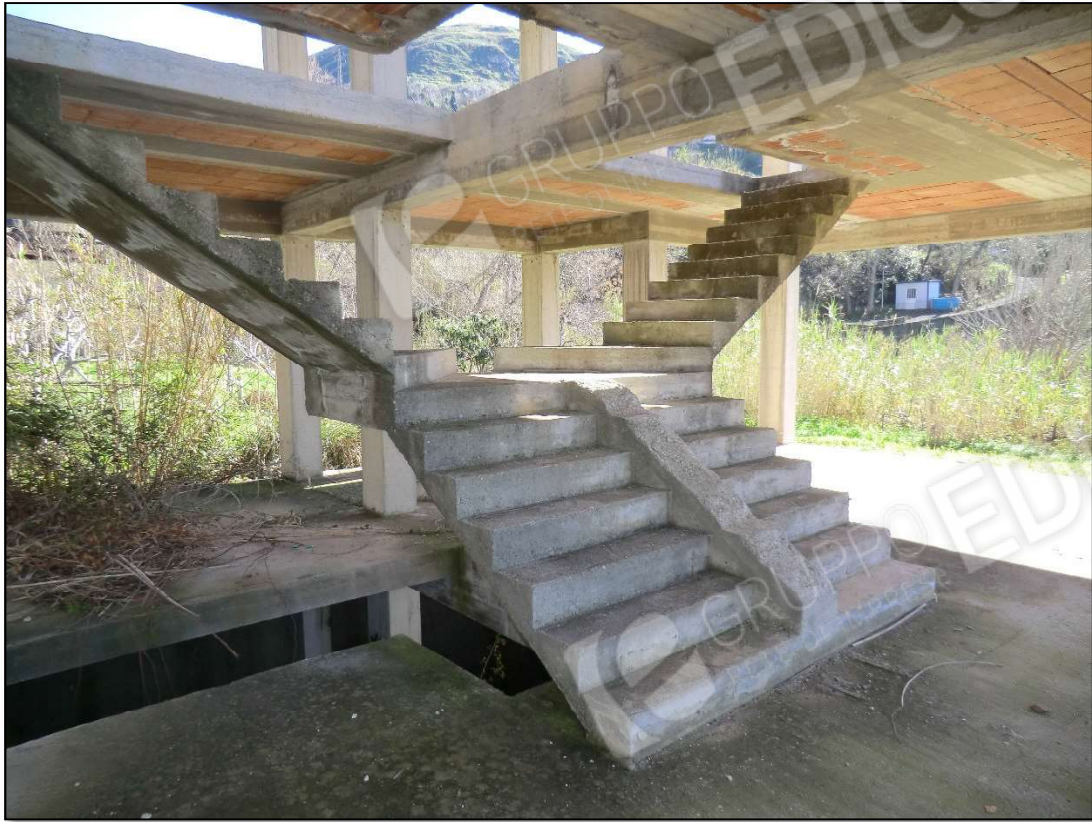
Foto 13_piano terra vista verso sud
