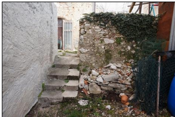
foto 21 - Scalinata e muro a confine
