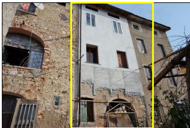
foto 2 - Abitazione vista dalla corte comune
