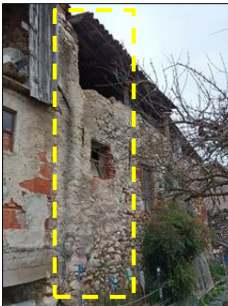
foto 16 - Prospetto verso valle
