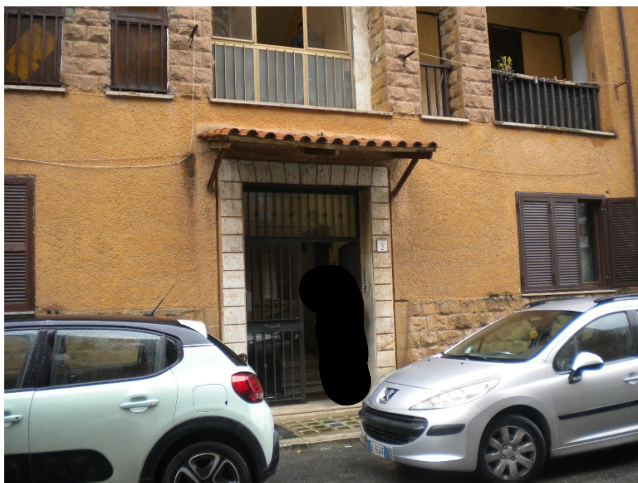
Foto 2- Particolare ingresso scala.
