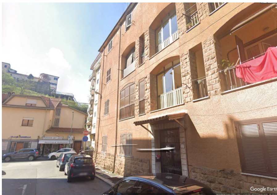
Foto 1- Panoramica edificio lato ingresso principale
