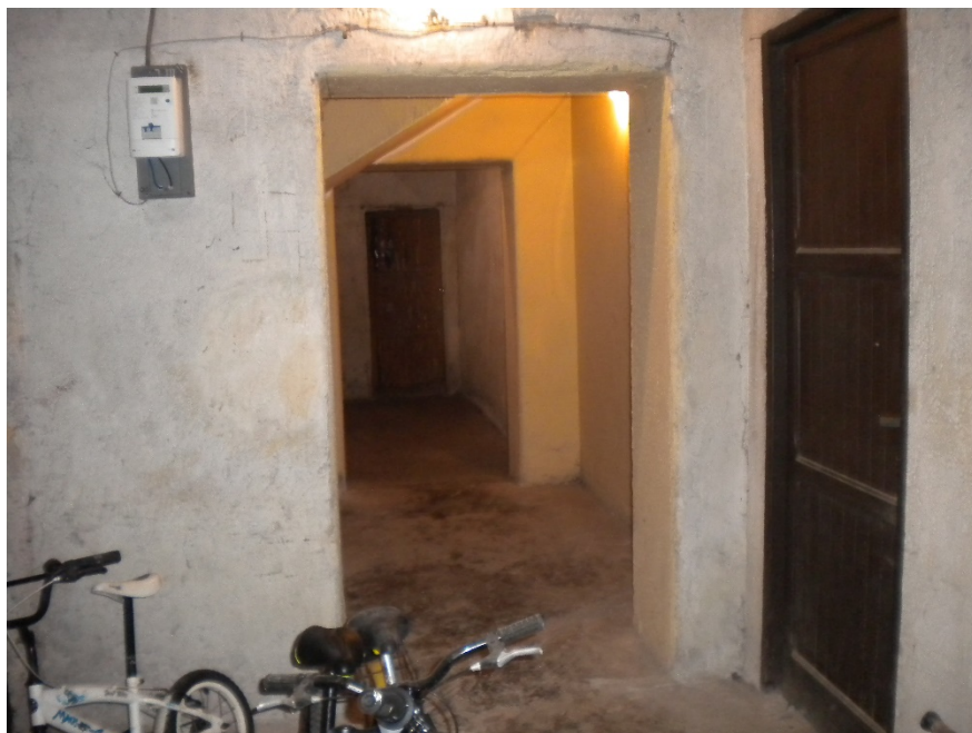
Foto 19- Corridoio piano interrato
