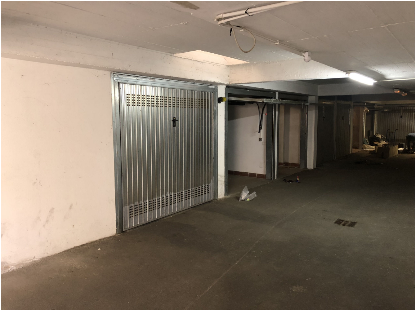
foto10_p.interrato_box auto (terzo da sinistra)
