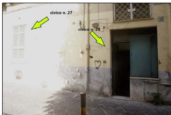
Fig. 3a Ingresso al cespite dalla strada
