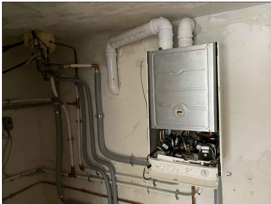
Foto 13 interno piano interrato
