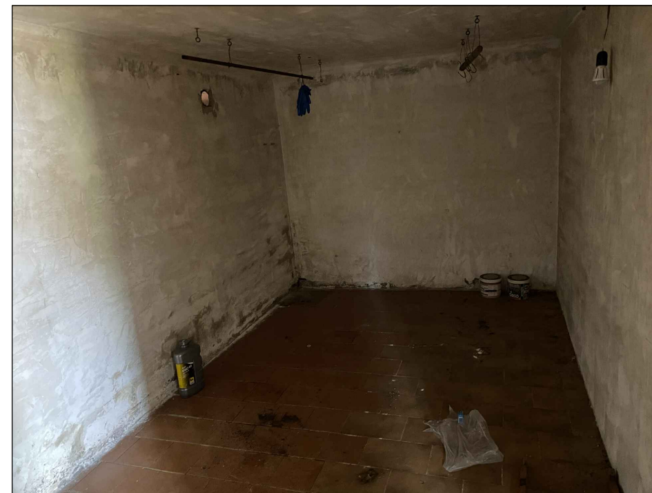
Foto 14 interno piano interrato
