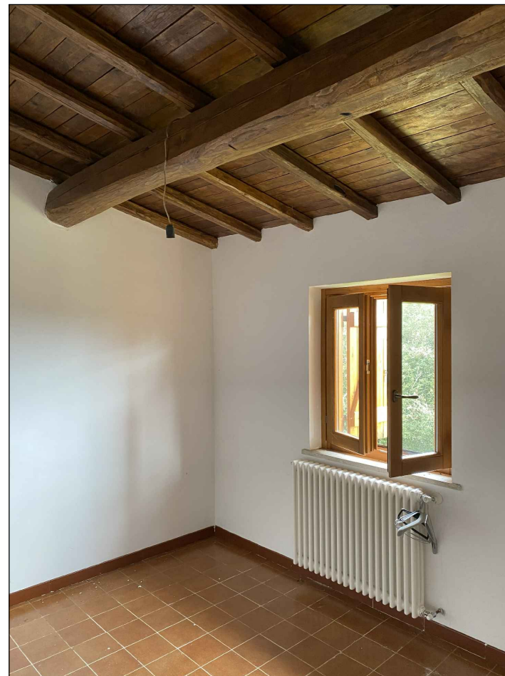
Foto 10 interno piano terra
