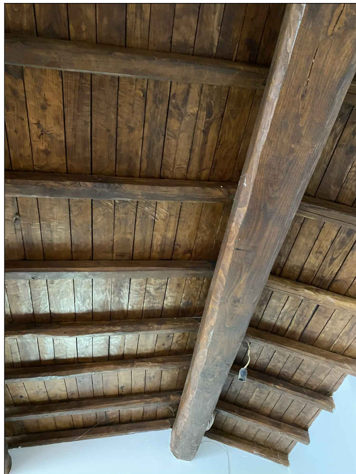
Foto 9 interno piano terra
