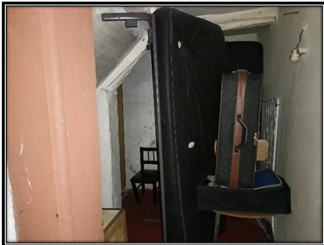
Ripostiglio sottoscala porzione 1
