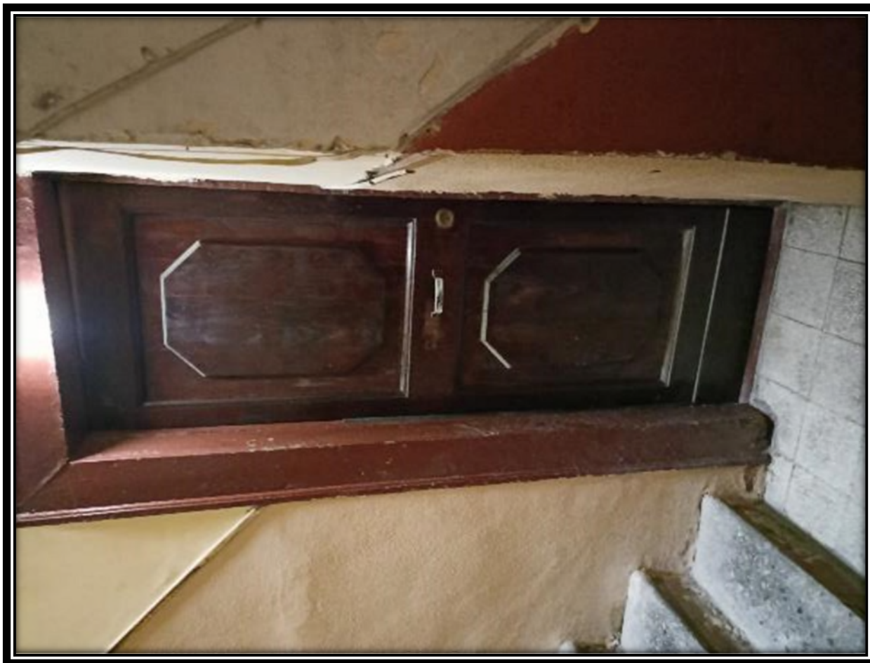
Portone ingresso porzione 1 su pianerottolo
