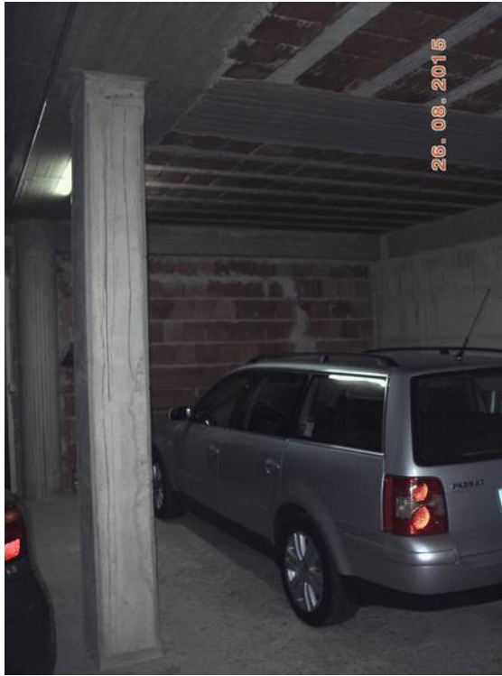
Vista interna - garage
