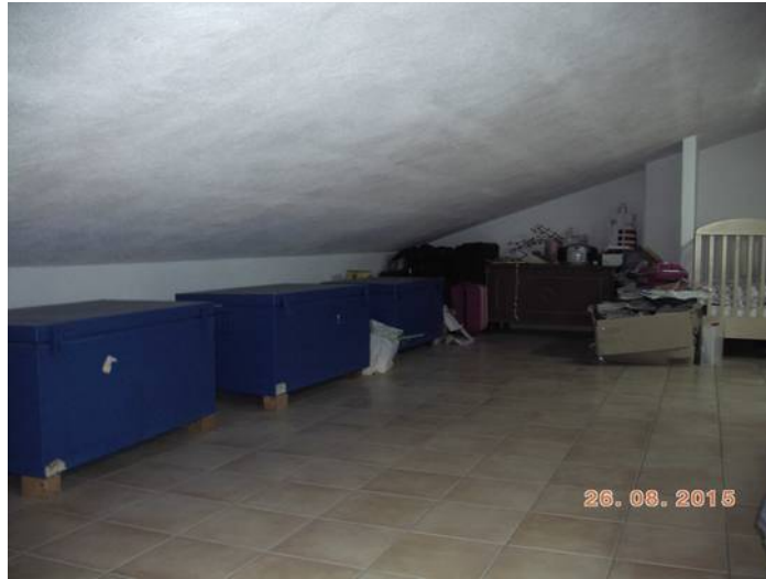
Vista interna - soffitta
