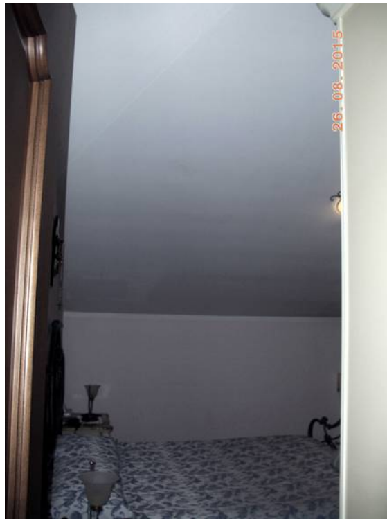
Vista interna - mansarda
