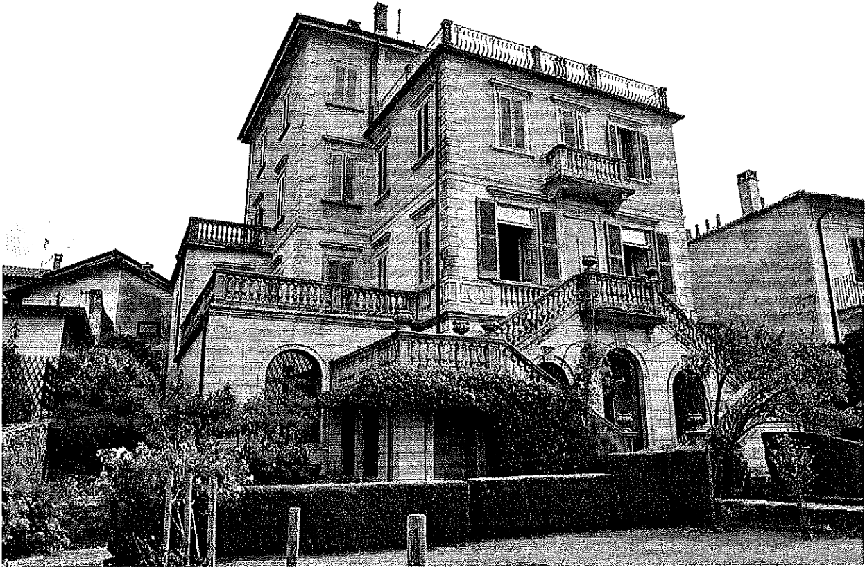
Vista del fabbricato 1193 ripreso da sud dal giardino di cui all'area pertinenziale destinata a giardino mappale 1193
