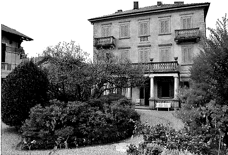
Vista dalla corte mappale 1193 posta a nord del fabbricato 1193
