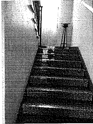
Vista scale ingresso
