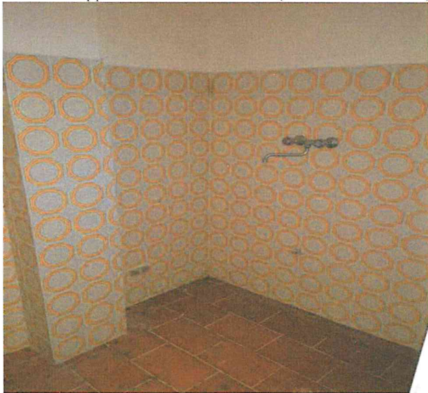
Foto n.3- Cucina Sub. 18-P2 (foto del 22.01.2020)
