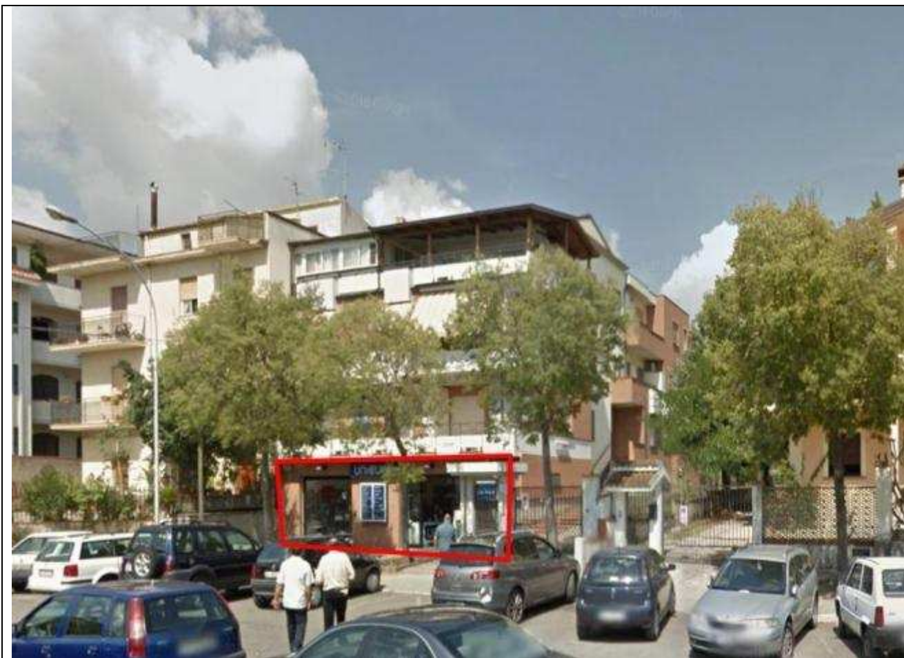
Immagine di parte dell'edificio di Via Polisportivo – Riquadrata in Rosso U.I.A. Catastale Fg. 24 P.Illa 615 subb. 28, 29
