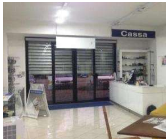
Particolare serranda – vista interna
