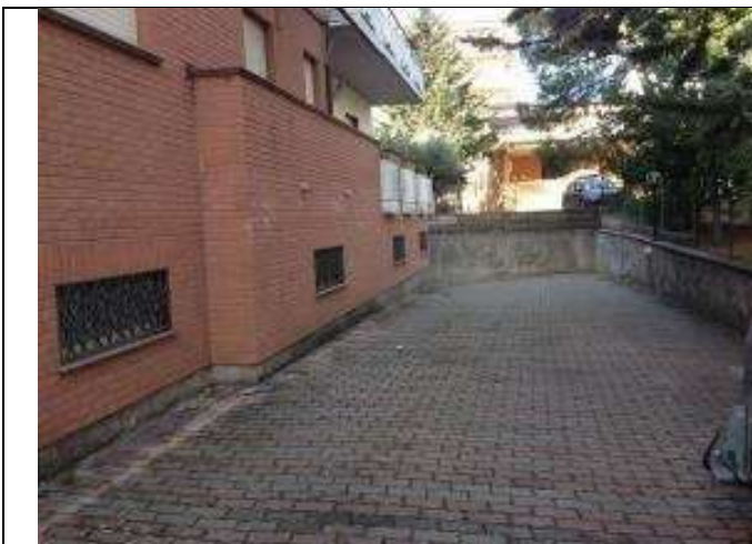
Particolare inferriata finestre a "bocca di lupo" – vista esterna
