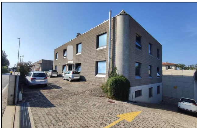
Vista frontale lato nord-est
