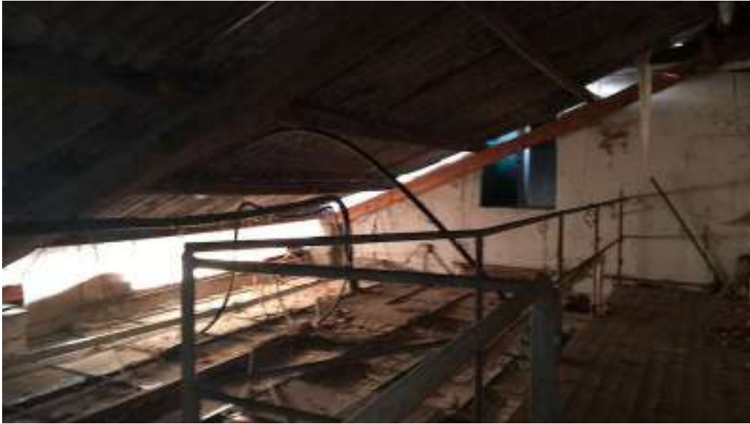
21. Piano primo ingresso soffitta
