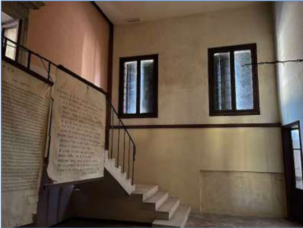
09. Locale vano scala
