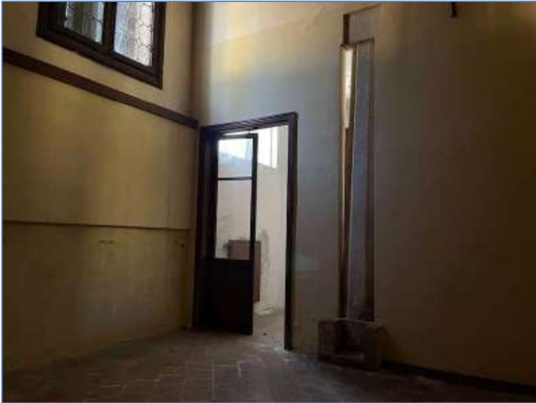
11. Locale vano scala
