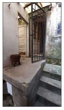
il modesto secchiaio ha pareti di laterizio intonacate; coperto realizzato con modesta struttura lignea portante e onduline in plastica; pavimento in calcestruzzo; porta di accesso di legno; alcune superfici sono rivestite parzialmente con elementi di ceramica; presente all'interno del locale un lavello in marmo;
