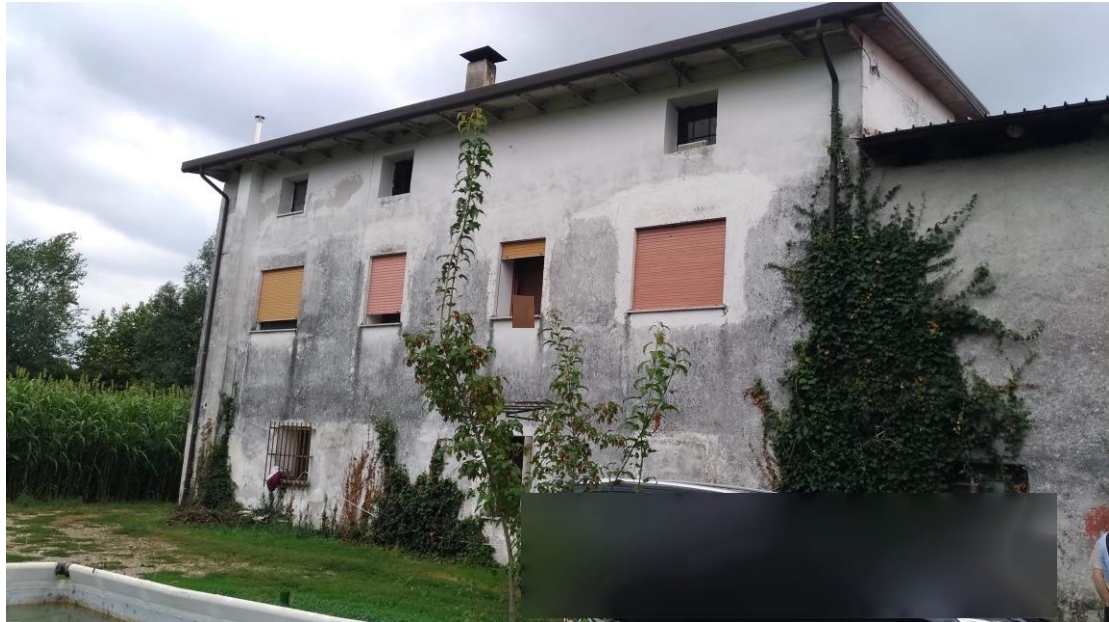
2. Vista generale da Nord - Ovst
