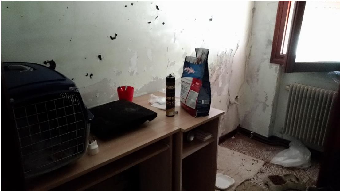
11. Vista del ripostiglio al piano terra
