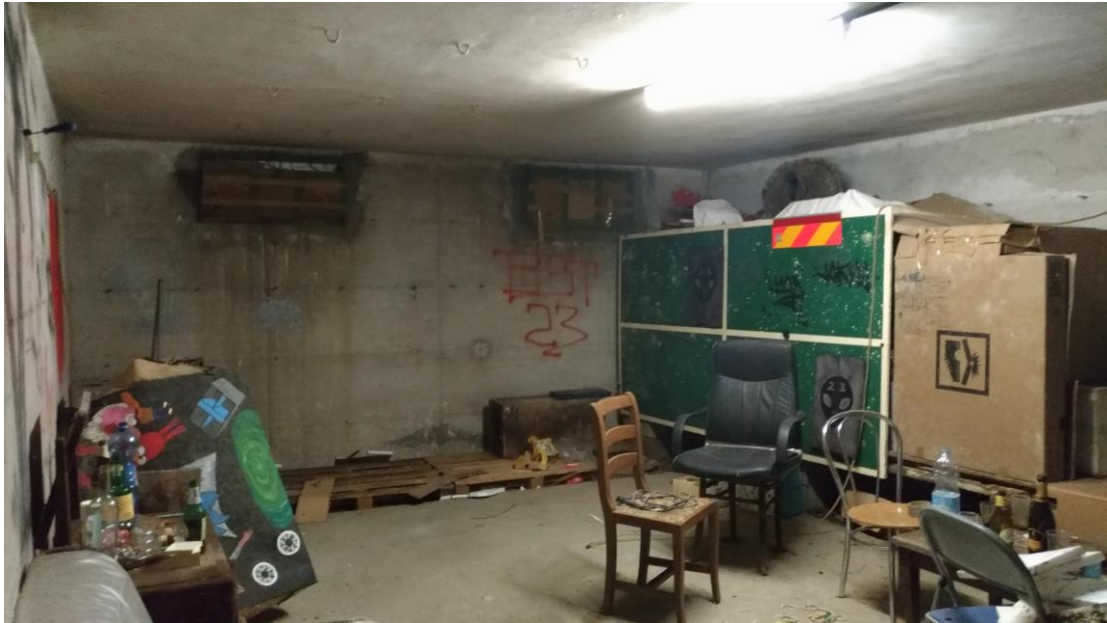
13. Vista della cantina al piano interrato
