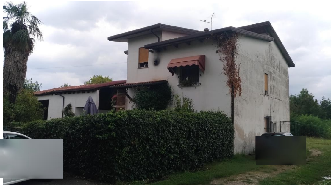
1. Vista generale da Sud-Est
