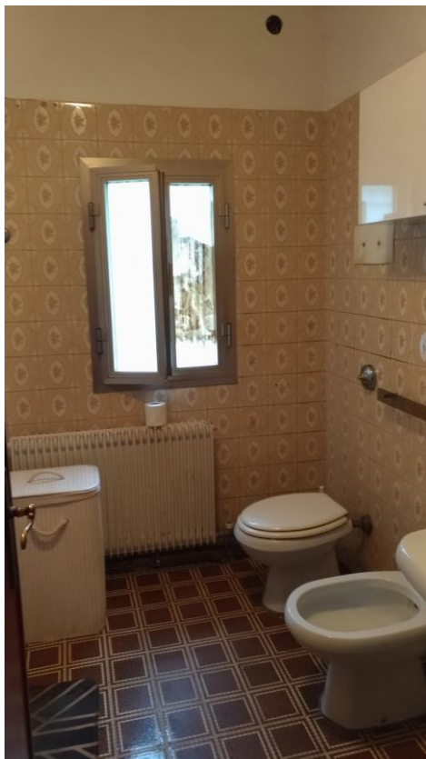
10. Vista del servizio igienico al piano terra
