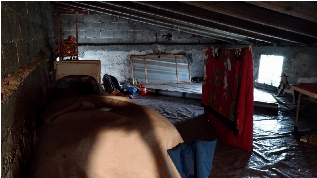
21. Vista della soffitta
