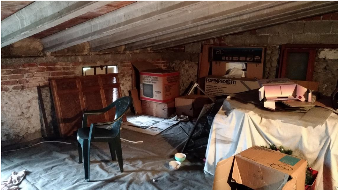
22. Vista della soffitta
