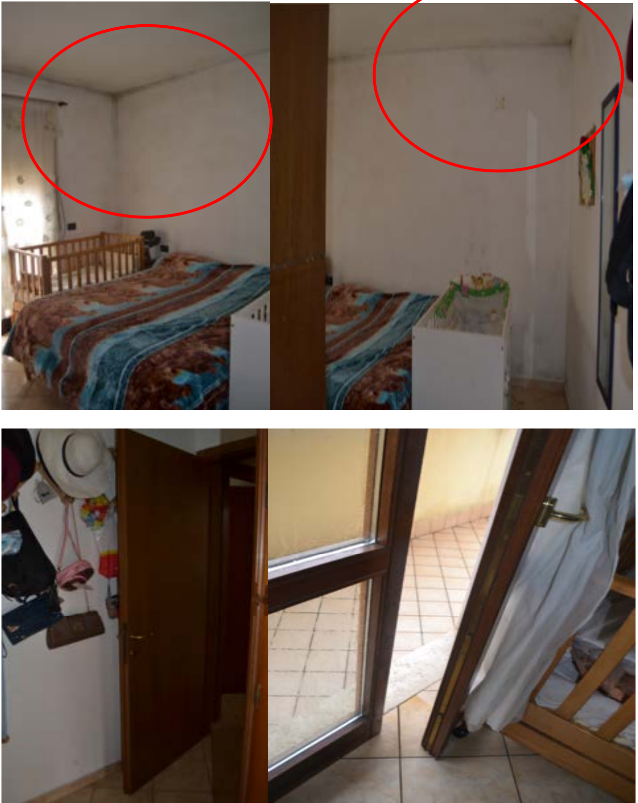
Figure 14 – Ingresso camera matrimoniale, visuale della stanza e porta finestra con accesso sulla terrazza
