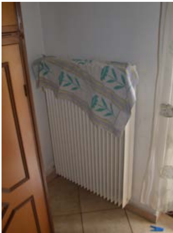
Figure 17-18 – Elemento riscaldante a colonne- Caldaia Murale esterna
