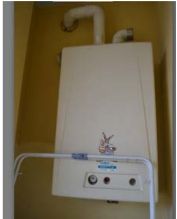
Figure 17-18 – Elemento riscaldante a colonne- Caldaia Murale esterna
