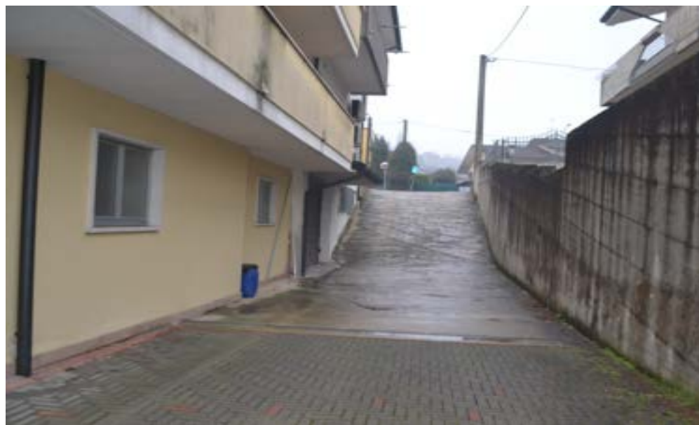
Figura 22 – Rampa di accesso all'autorimessa
