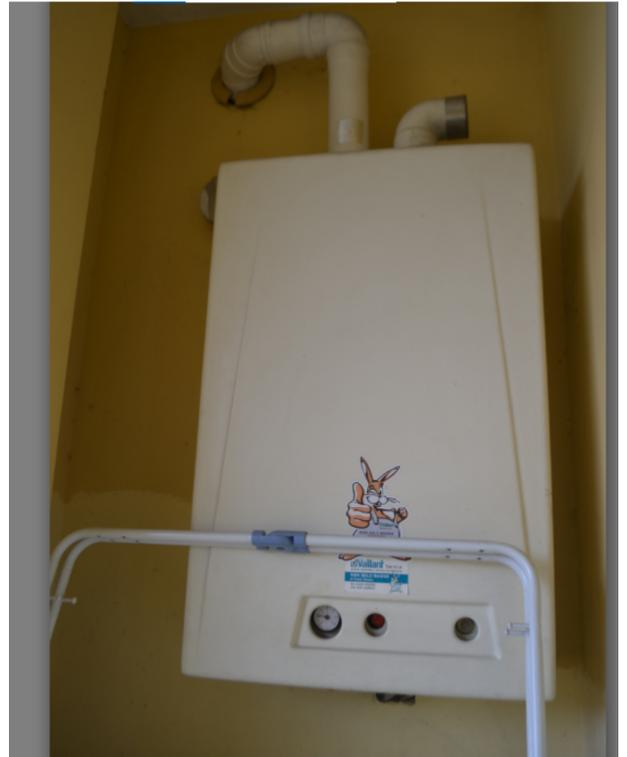
**Figure 15-16 – Elemento riscaldante a colonne- Caldaia Murale esterna**
