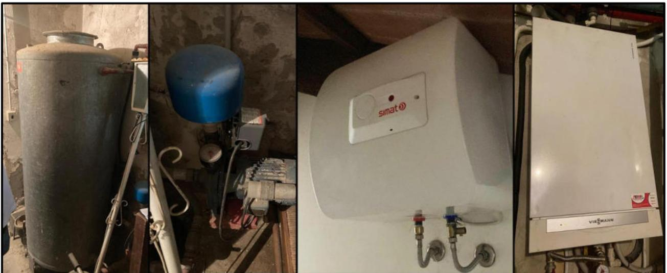
Impianto idrico: serbatoio e pompa in V.T; boiler elettrico (ACS al PT); caldaia a metano (ACS al P1)
