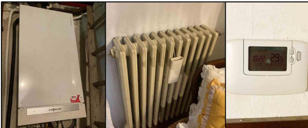
**Impianto riscaldamento principale: caldaia, radiatore e cronotermostato**
