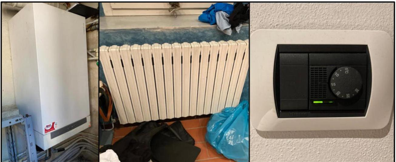
**Impianto riscaldamento principale: caldaia, radiatore e cronotermostato**
