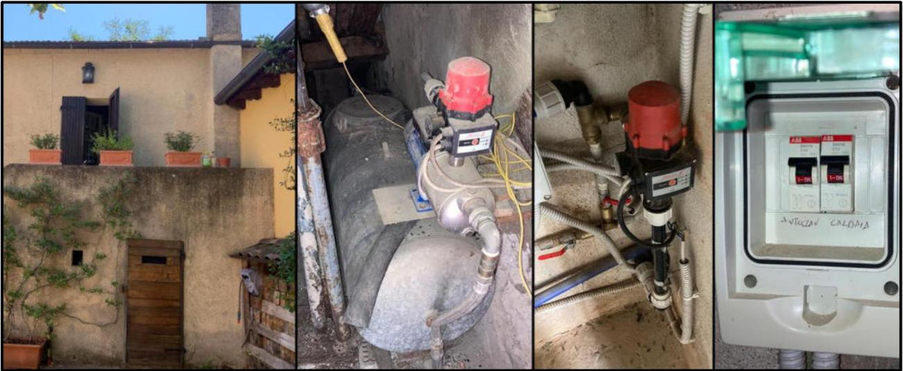
Impianto idrico: vano tecnico con serbatoio, pompa di sollevamento e quadretto dedicato
