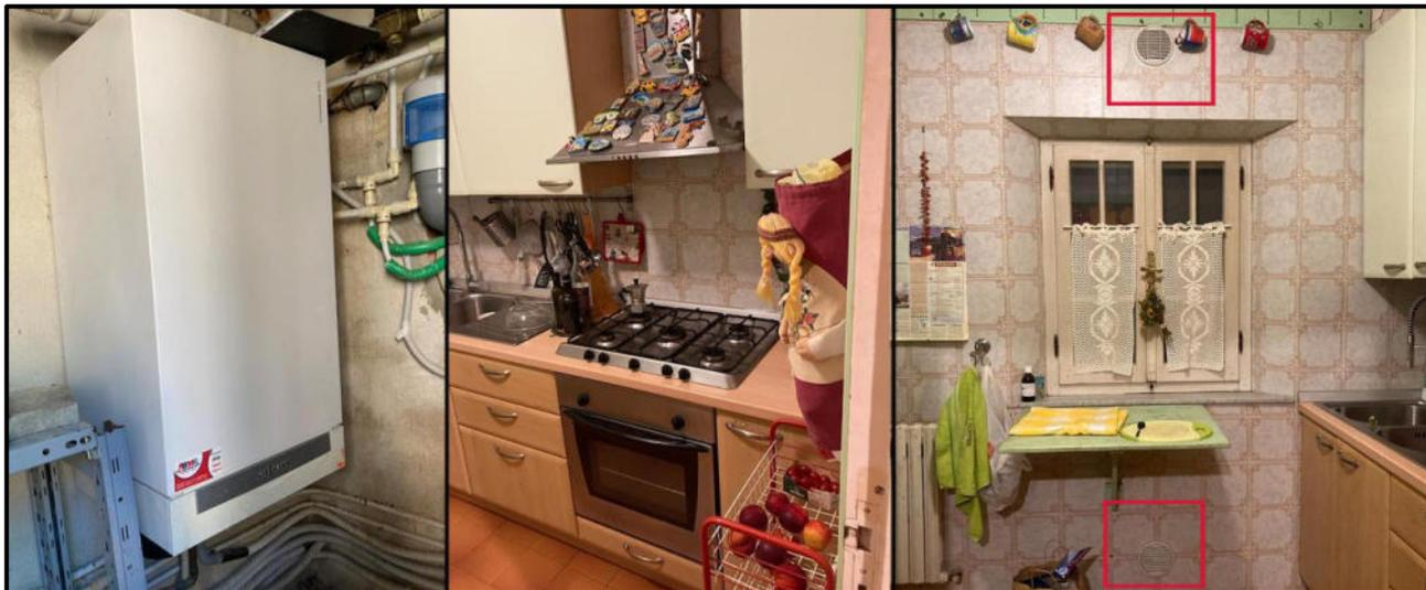
Impianto gas: caldaia, piano cottura e fori areazione/ventilazione
