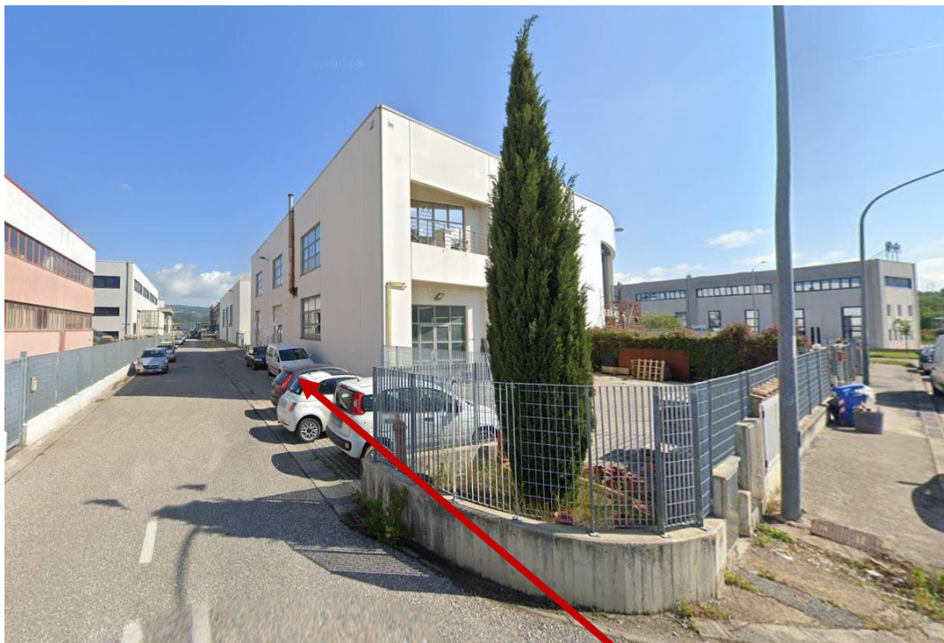
Foto 1 - Edifici in via Nove: l'ingresso al n.31
