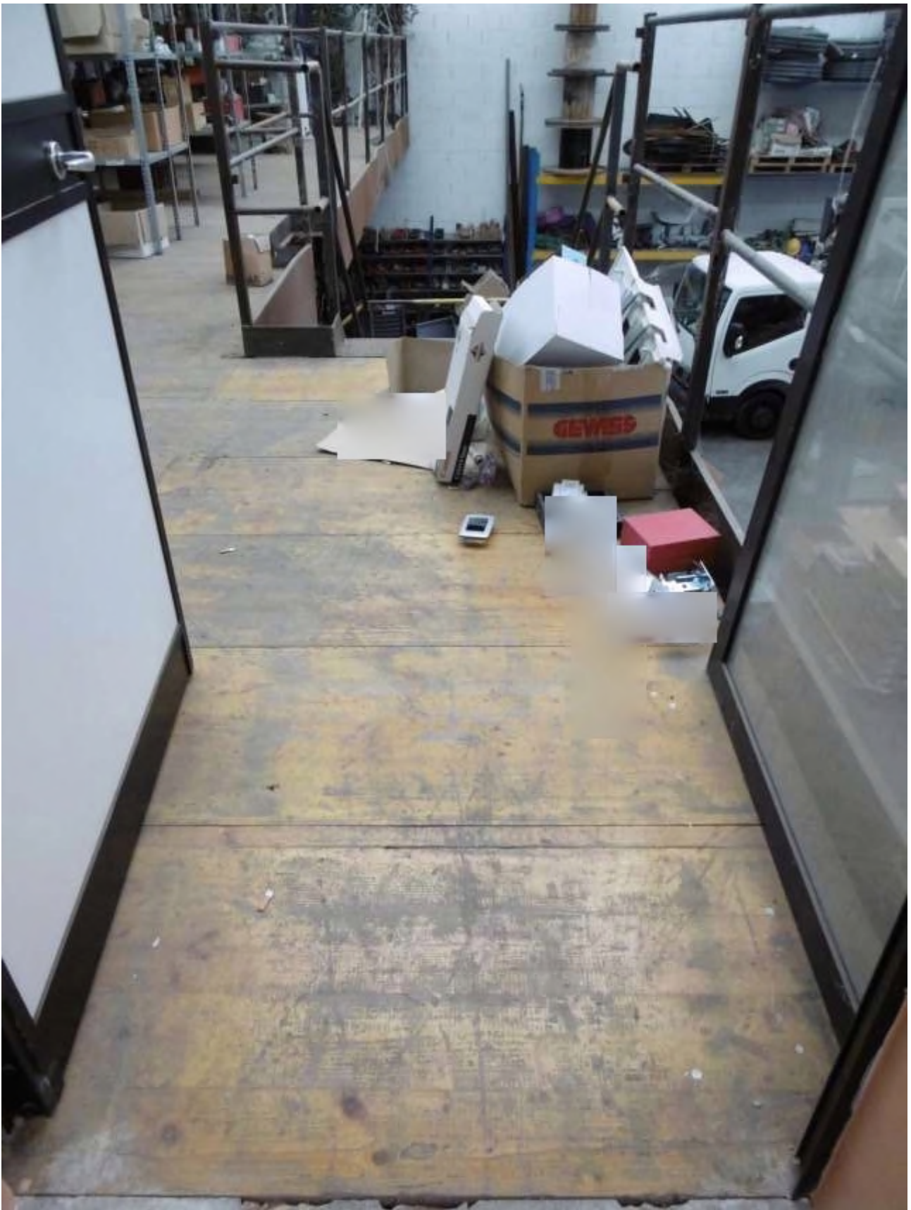
COLLEGAMENTO AL PIANO PRIMO SOPPALCATO. OTTENUTO TRASFORMANDO UNA FINESTRA DEL VANO SCALA IN PORTA PER CONSENTIRE IL PASSAGGIO.
