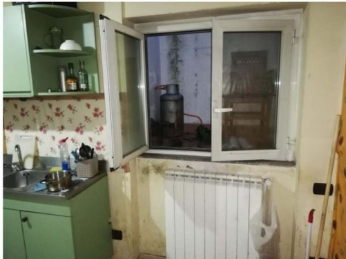
PIANO INTERRATO - CANTINA
