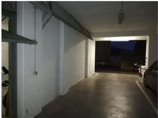
BOX SUB 18 ACCESSO
