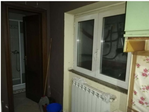
PIANO INTERRATO - CANTINA
