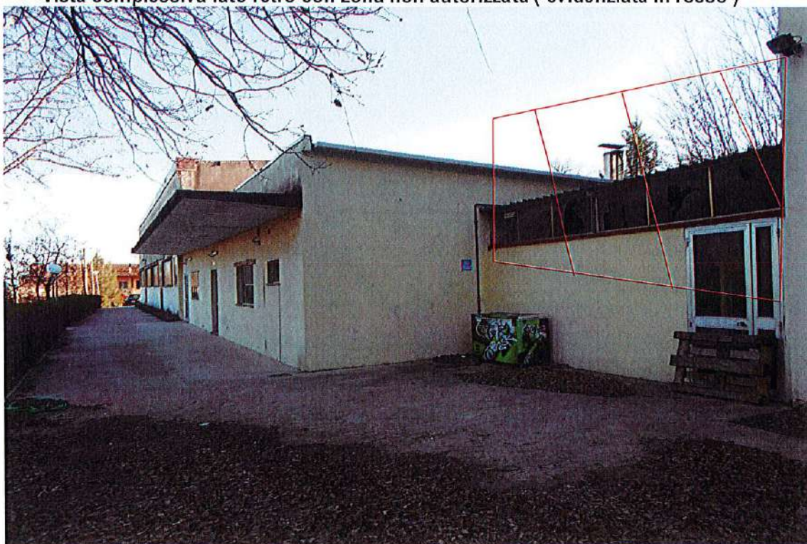
Vista complessiva lato retro con zona non autorizzata ( evidenziata in rosso )
