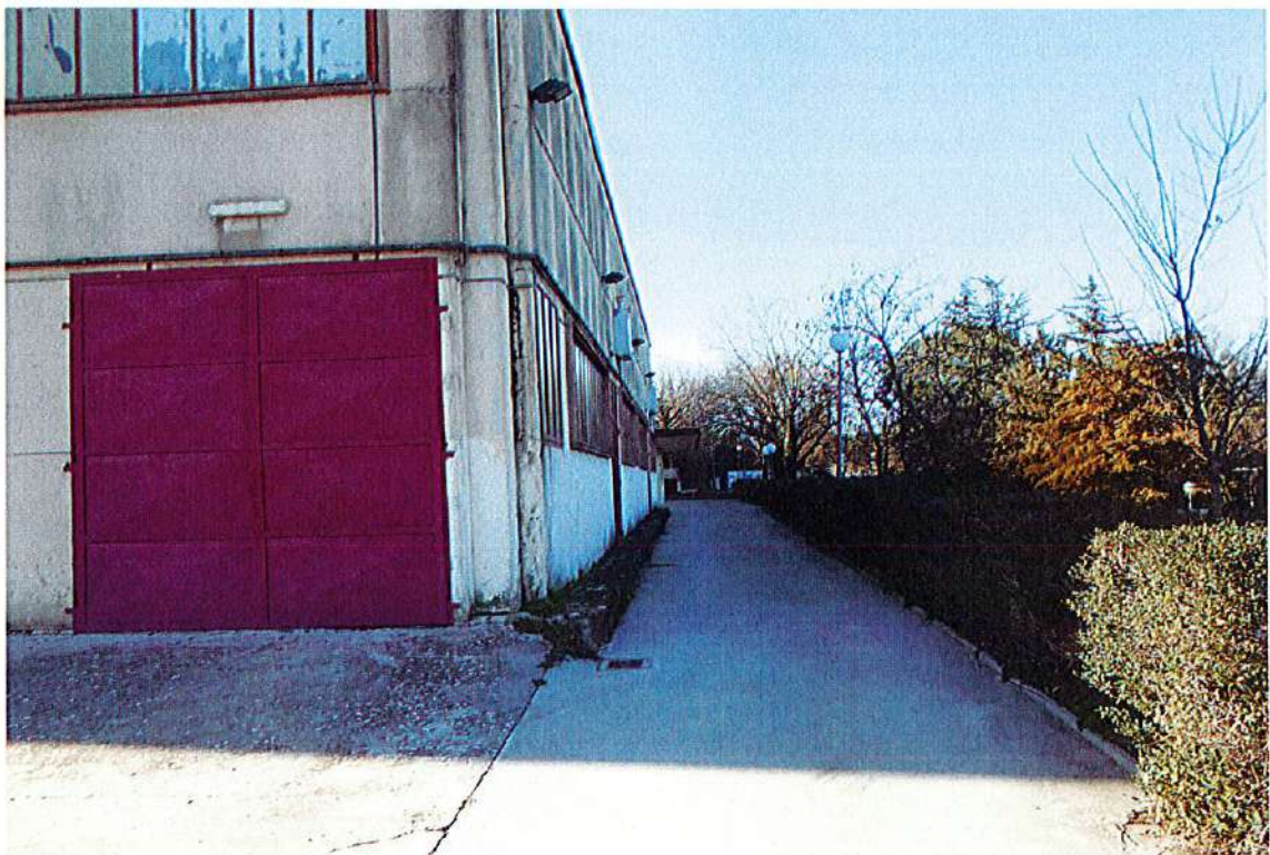
Vista laterale fabbricato polivalente
