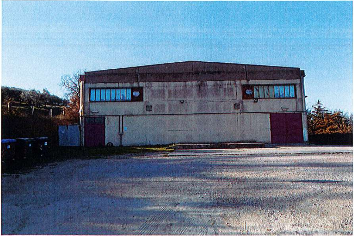
Vista frontale edificio polivalente
