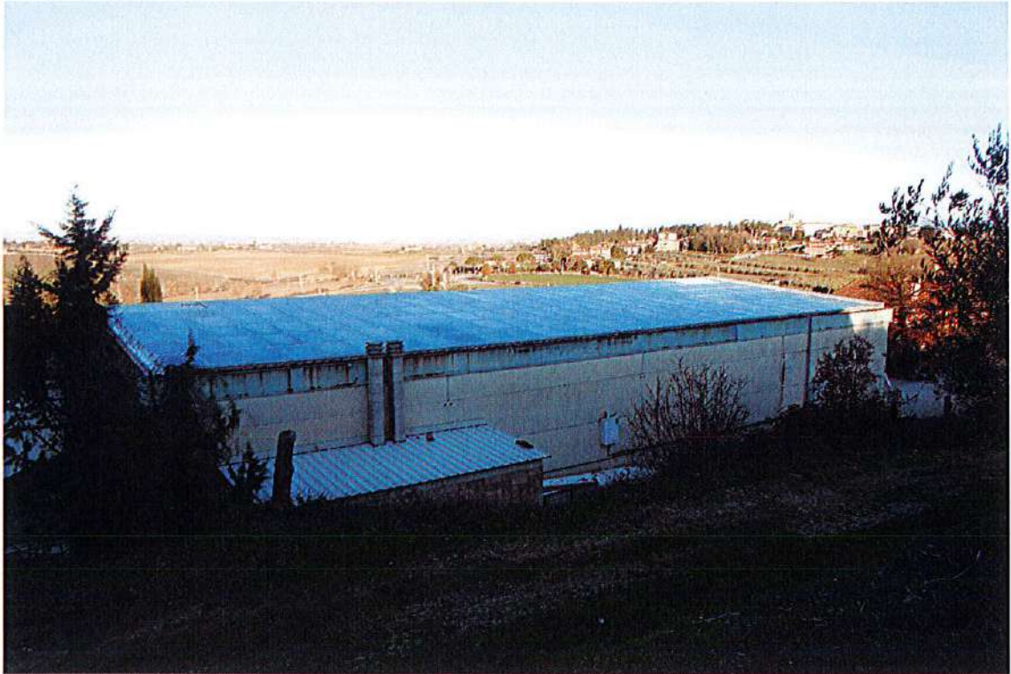
Vista complessiva impianto fotovoltaico
