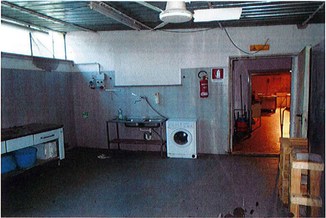
Locale non regolarizzato tra ristorante e cucina
