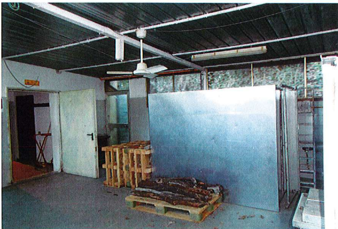
Locale non regolarizzato tra ristorante e cucina
