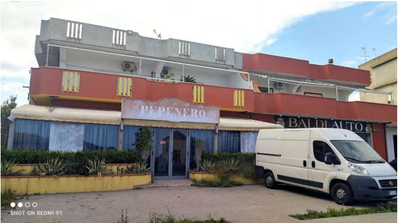
FABBRICATO PROSPETTO LATO STRADA NAZIONALE 106
