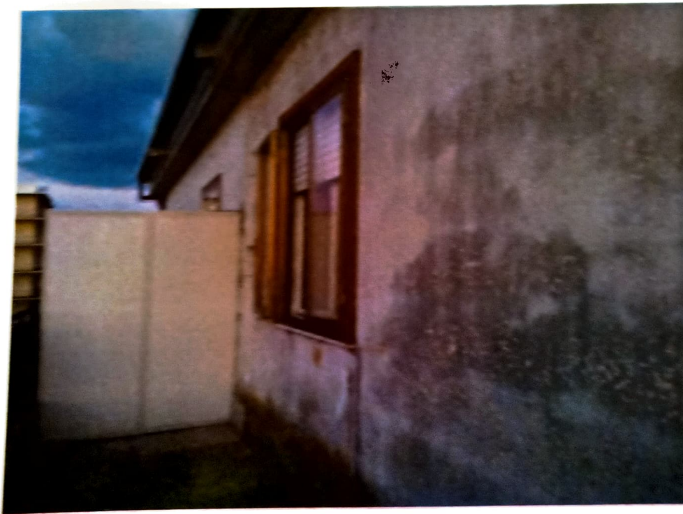
FOTO n.° 2 Prospetto su terrazza.
