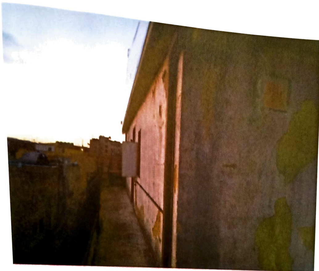
FOTO n.° 3 Prospetto su terrazza
