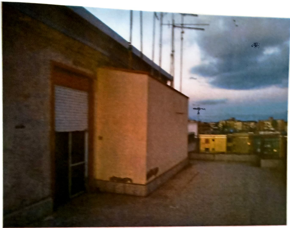
FOTO n.° 1 Prospetto su terrazza
