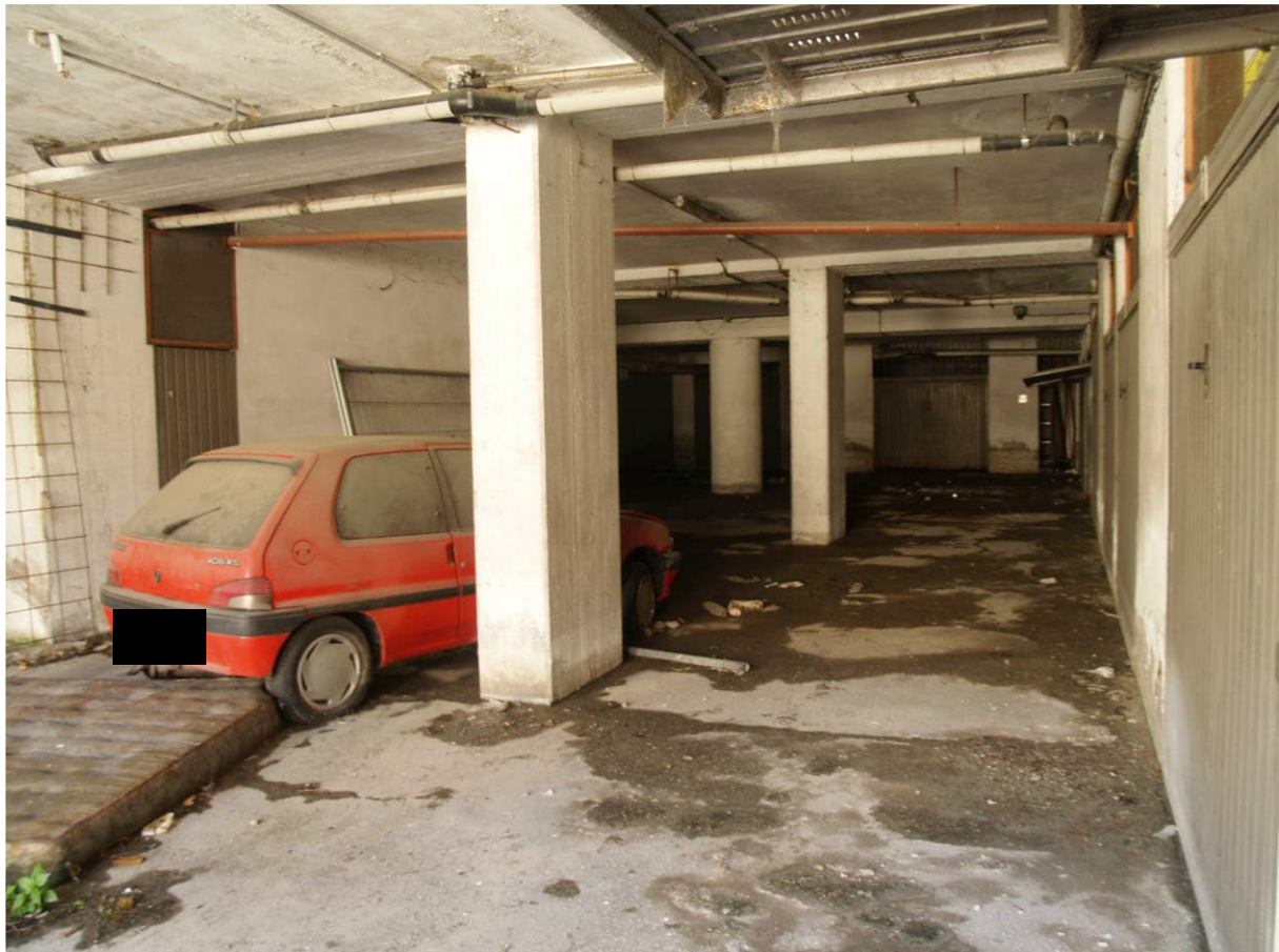
6. La corsia di manovra comune
