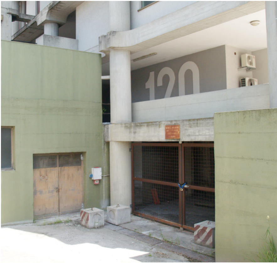
1. Ingresso comune al piano interrato
