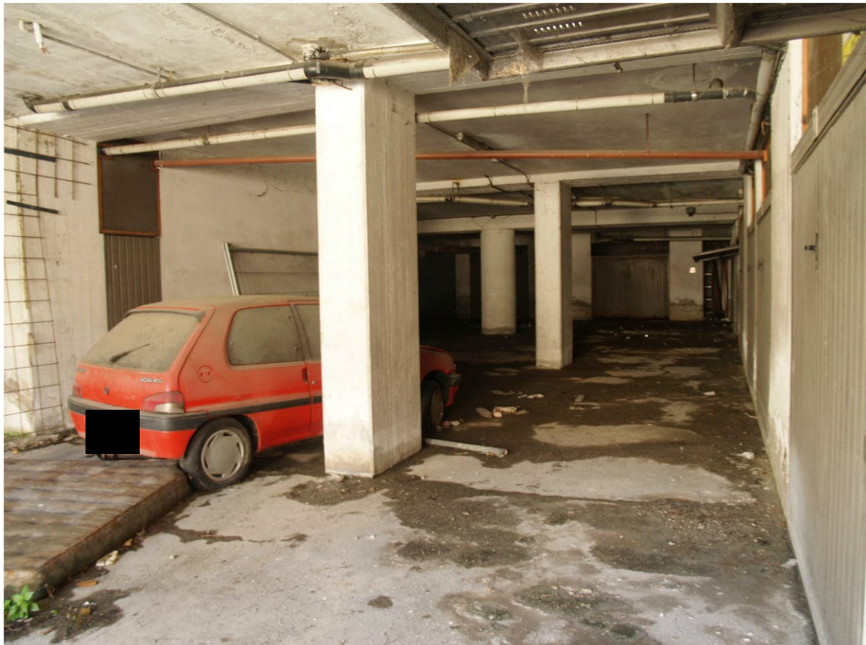
6. La corsia di manovra comune
