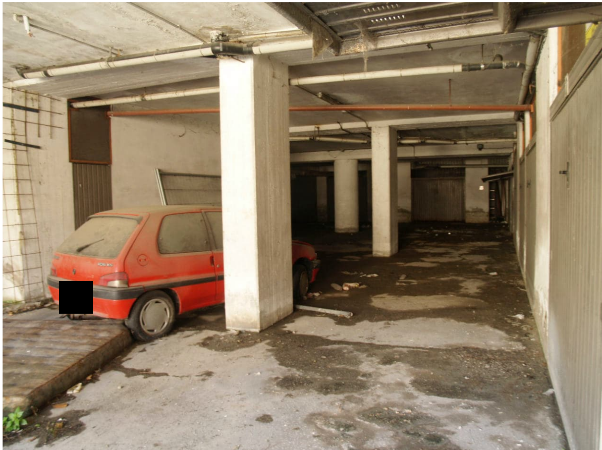
6. La corsia di manovra comune
