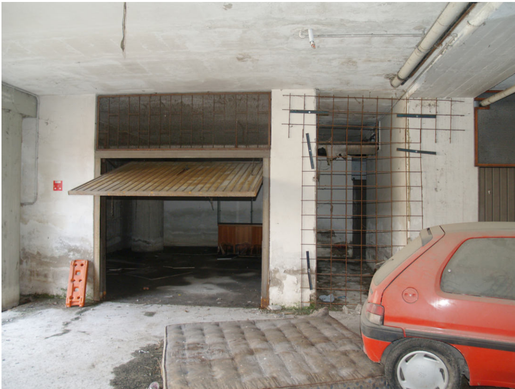
3. L'autorimessa in oggetto.
