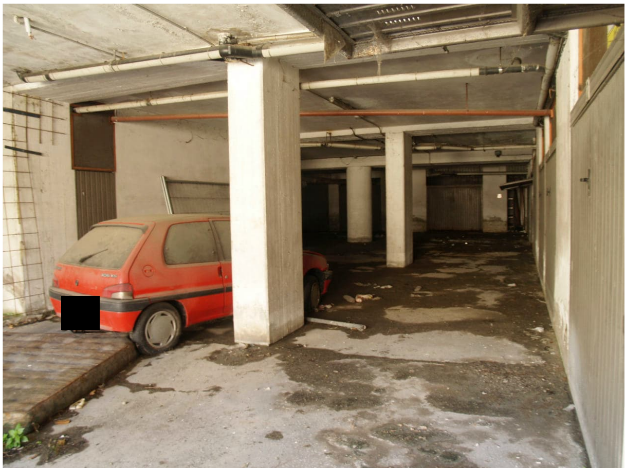
6. La corsia di manovra comune
