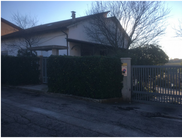
(vista fronte strada)
