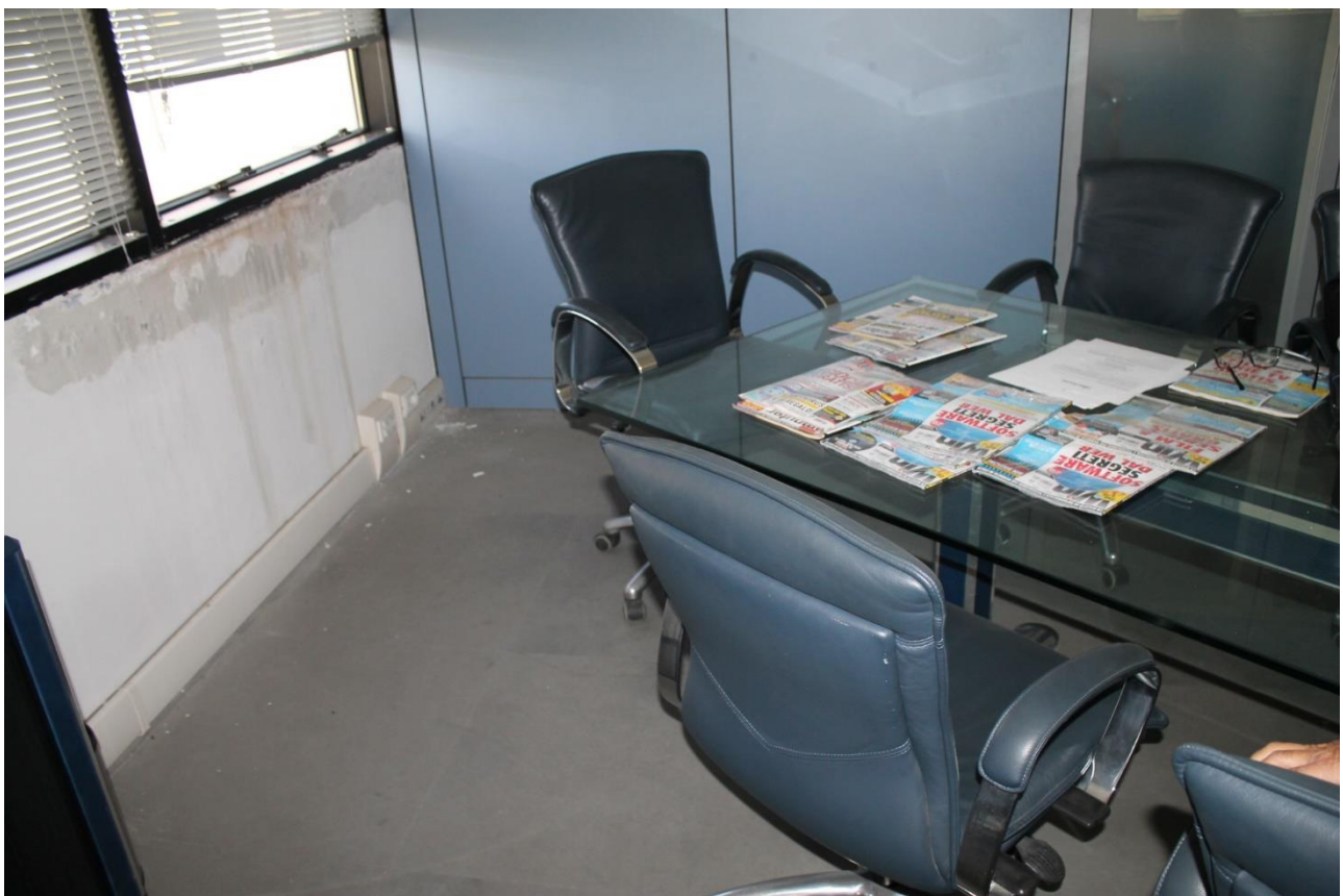
Foto n.22 – corpo uffici (p.IIa 347 sub. 3) – locali uffici
