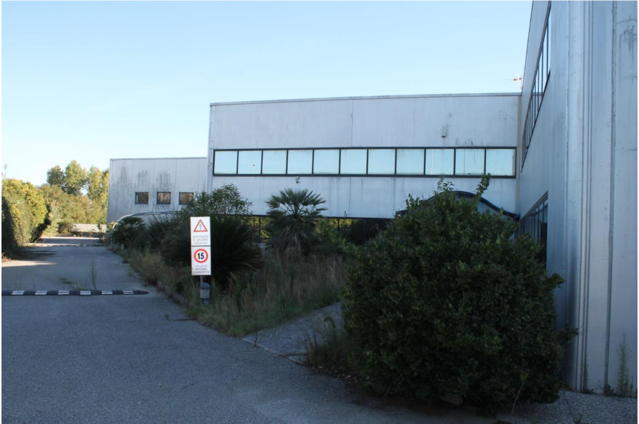
Foto n.15 – corpo uffici (p.lla 347 sub. 3) – ingresso
