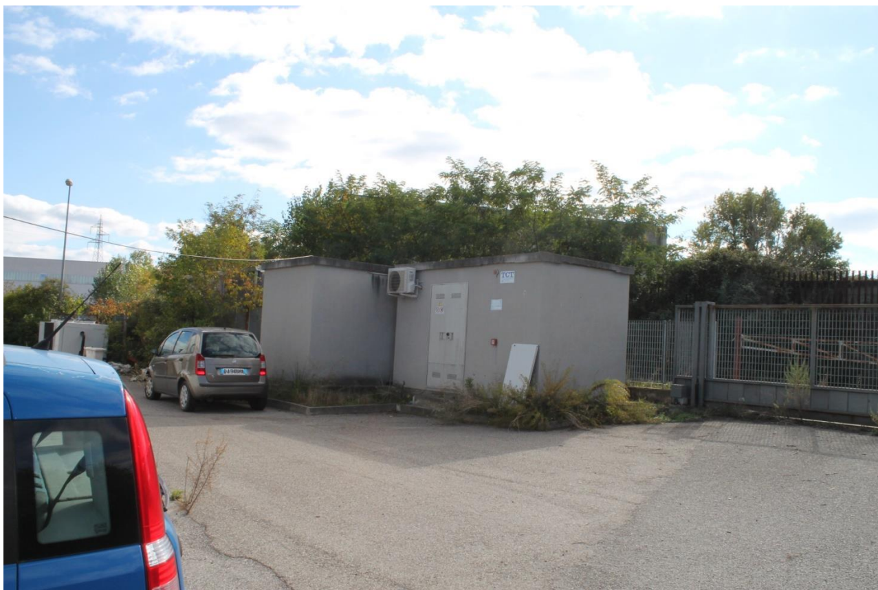
Foto n.25 – locali tecnici (p.la 498-499)
