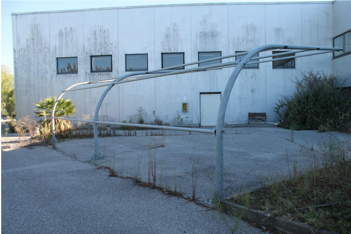
Foto n.3 – Capannone (p.la 346) – vista frontale
