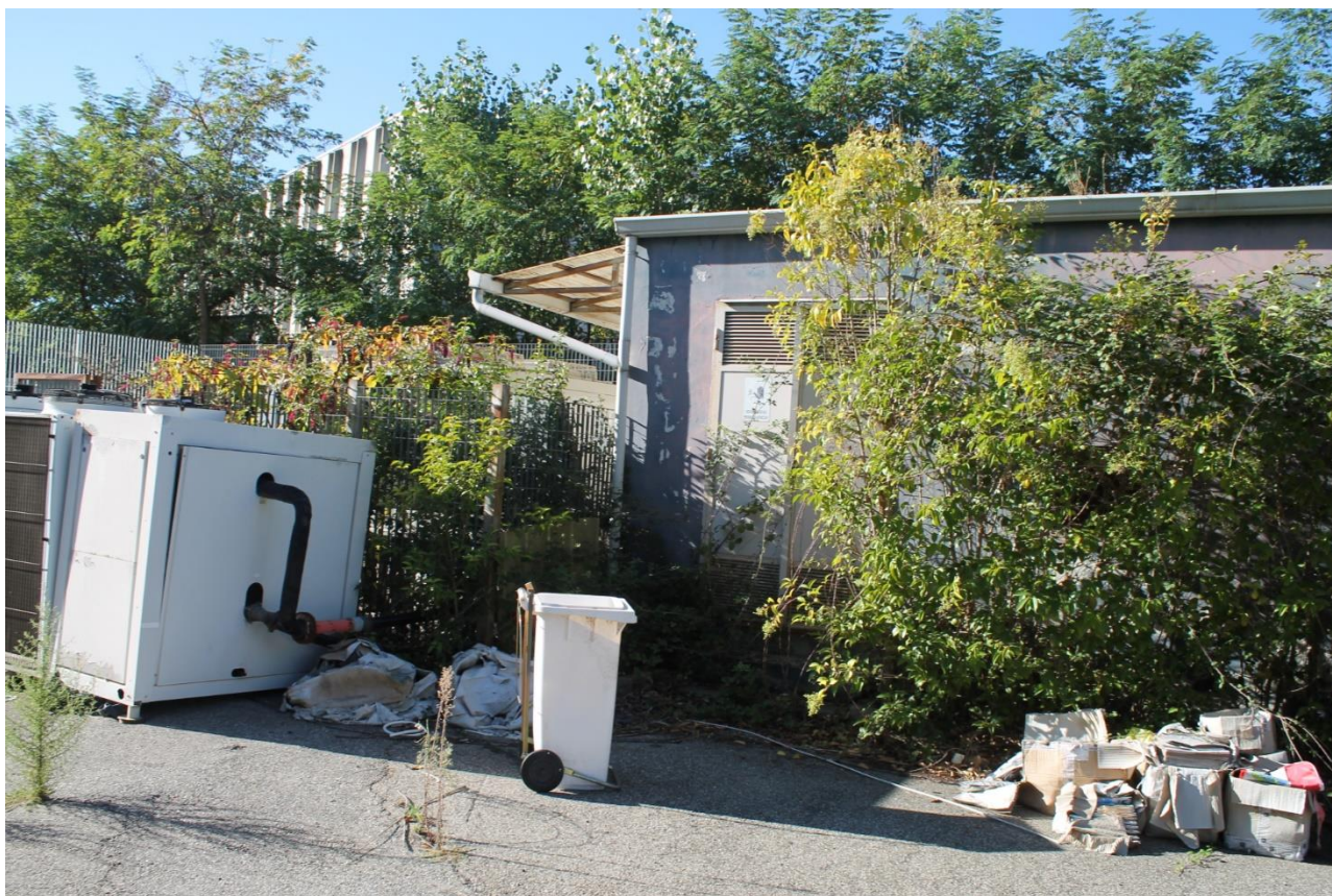
Foto n.27 – locali tecnici (p.lla 363)
