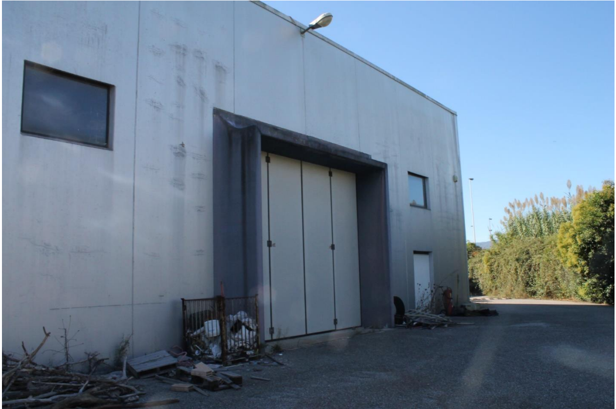
Foto n.1 – Capannone (p.lla 346) – ingresso vista laterale
