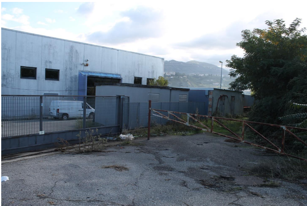
Foto n.28 – locali tecnici (p.lla 498-499-363) vista dall'esterno della recinzione
