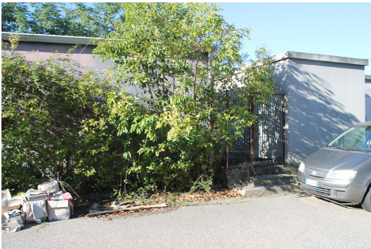
Foto n.26 – locali tecnici (p.la 363)
