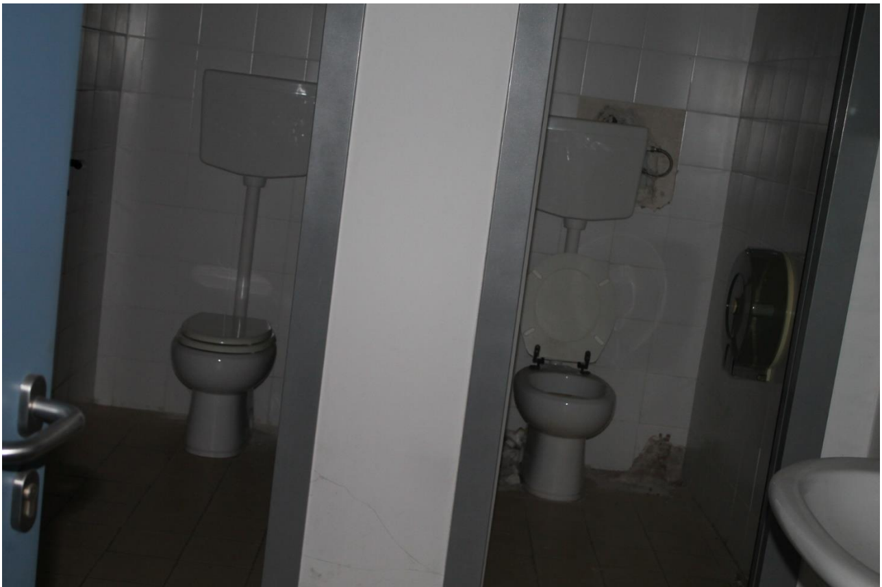
Foto n.24 – corpo uffici (p.IIa 347 sub. 3) – locali uffici
