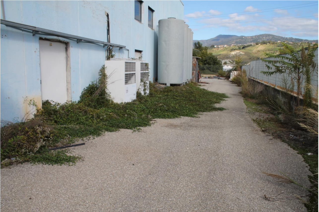
Foto n.5 – Capannone (p.lla 346) – vista laterale
