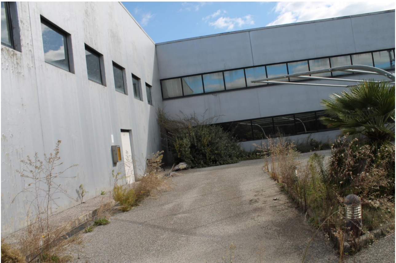
Foto n.18 – corpo uffici (p.lla 347 sub. 3) – prospetto laterale
