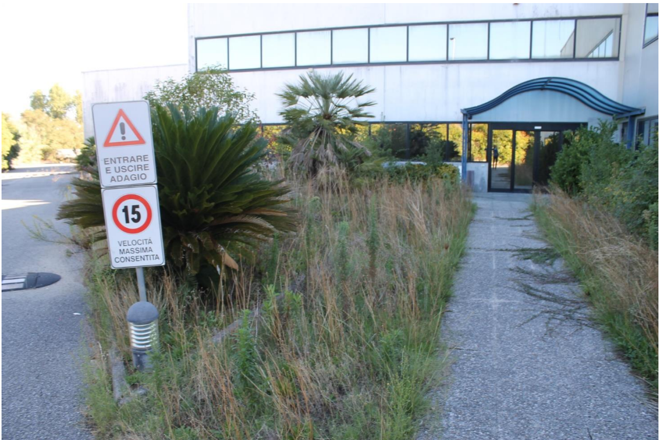
Foto n.16 – corpo uffici (p.lla 347 sub. 3) – ingresso
