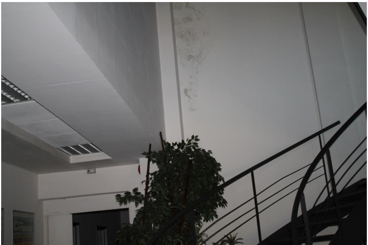
Foto n.20 – corpo uffici (p.la 347 sub. 3) – accettazione
