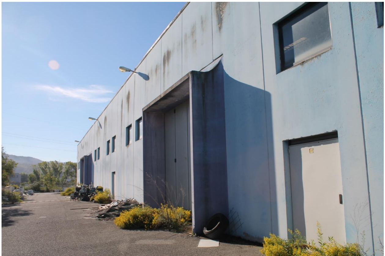
Foto n.2 – Capannone (p.lla 346) - - ingresso vista posteriore
