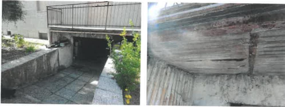
I locali servizio sono in pessimo stato manutentivo e conservativo, sono privi di pavimentazione, intonaco e tinteggiatura. Sono presenti estese macchie di umidità sulla muratura.
