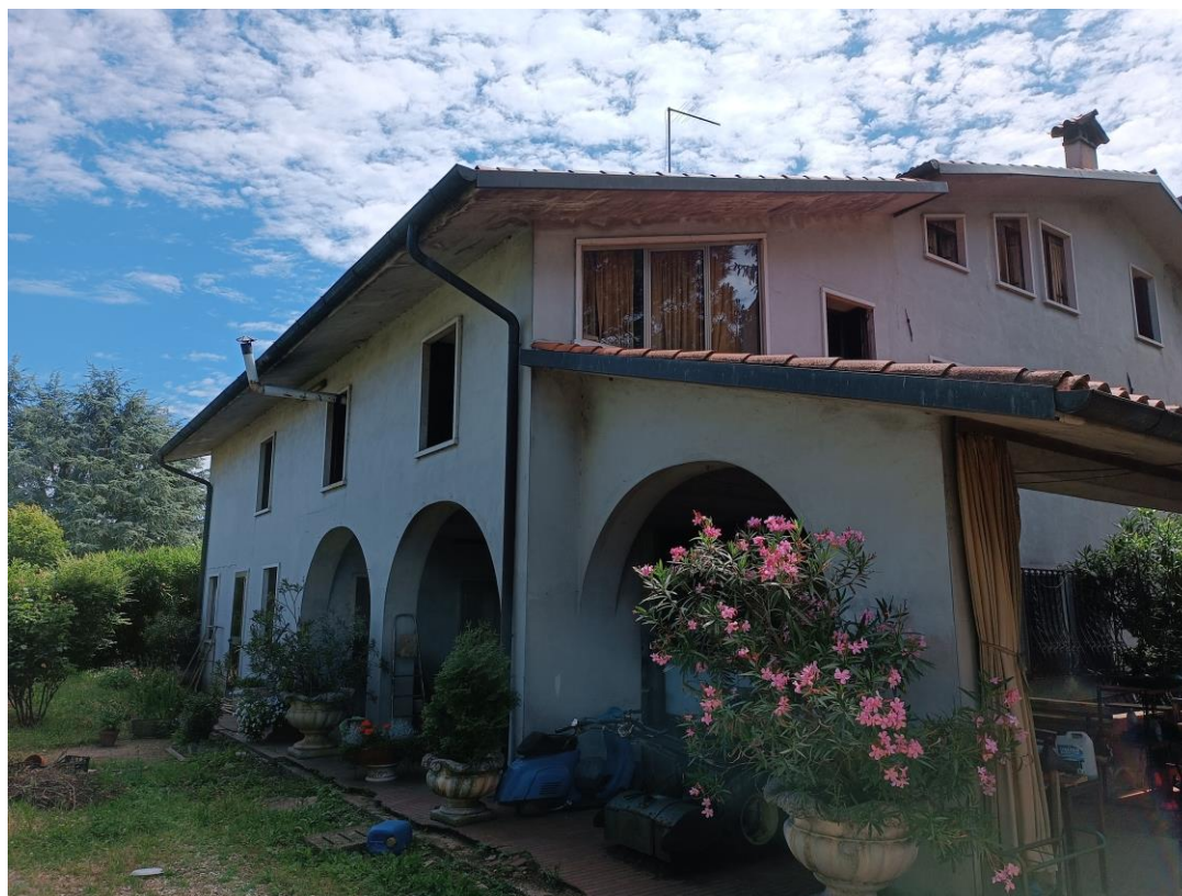
Foto n 1 – fabbricato residenziale unifamiliare
