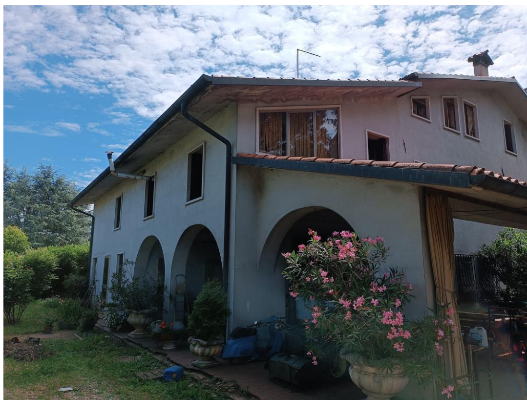
Foto n 1 – fabbricato residenziale unifamiliare
