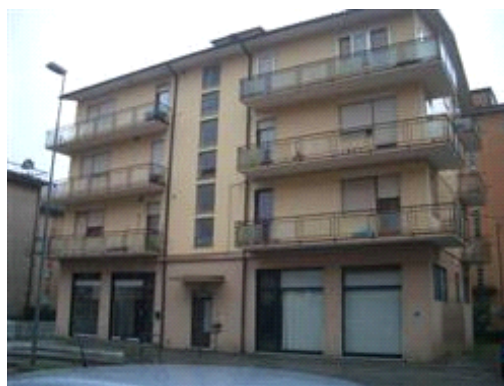
Vista generale da Nord-Est
