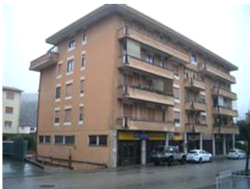
Vista generale da Nord-Ovest
