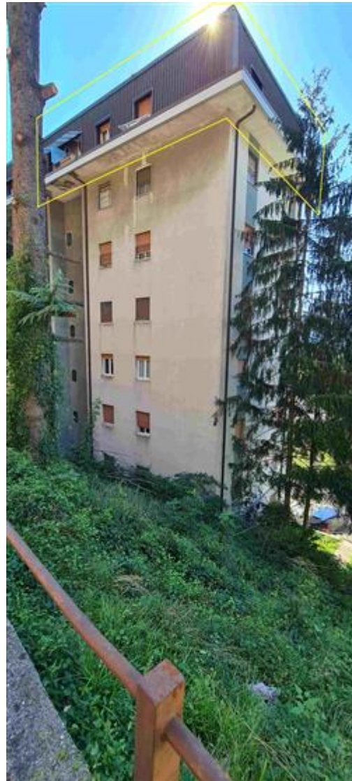
Vista esterna fronte nord-est.
