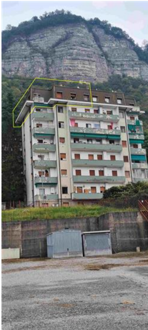
Vista esterna fronte sud-ovest.
