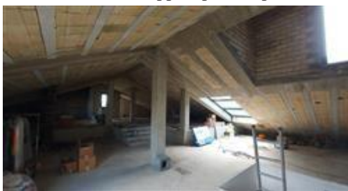
vista del piano sottotetto al grezzo
