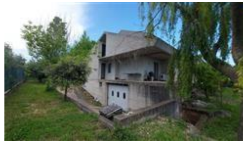
vista del prospetto laterale con rampa di accesso al magazzino
