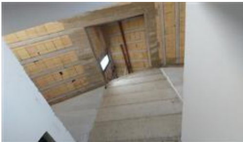
vista del vano scala di collegamento tra piano terra e sottotetto
