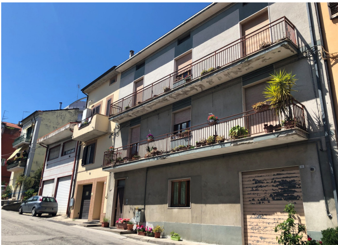
Foto esterna del fabbricato – Lotto A
