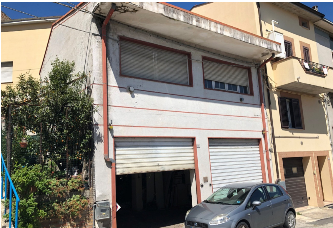
Foto esterna del fabbricato
