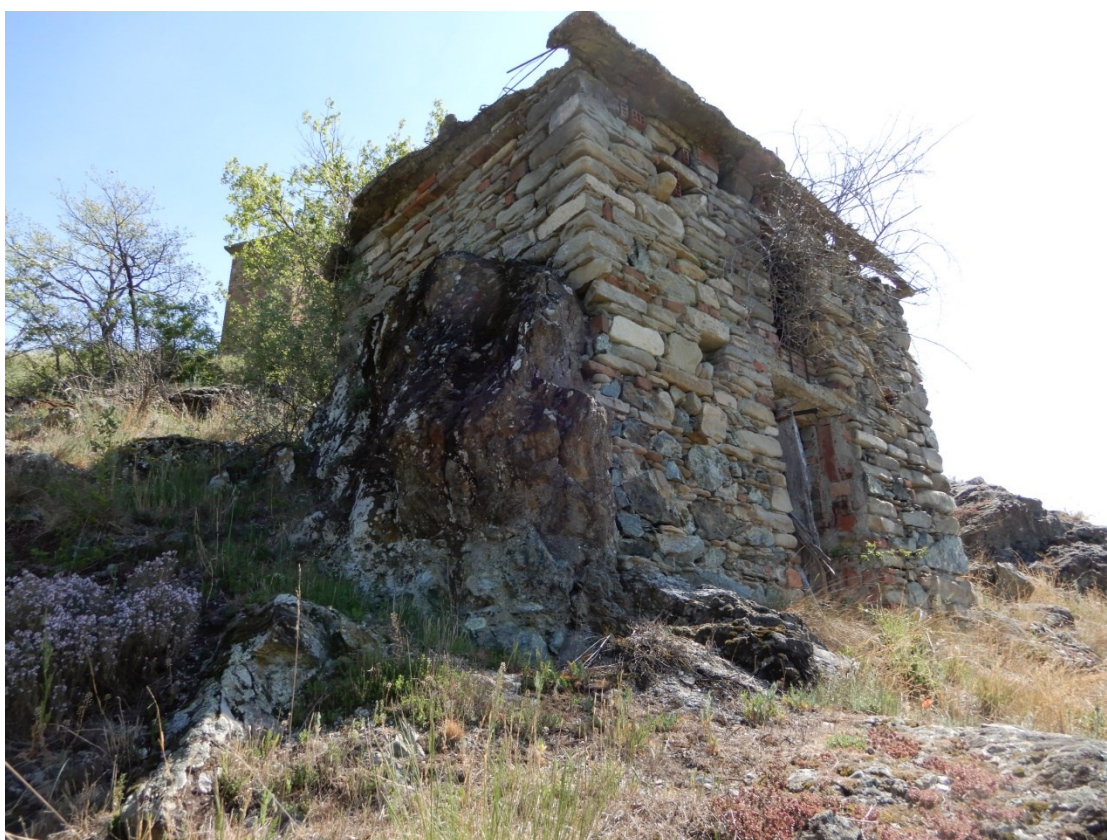
VISTA MAGAZZINO NEI PRESSI DEL TRALICCIO
