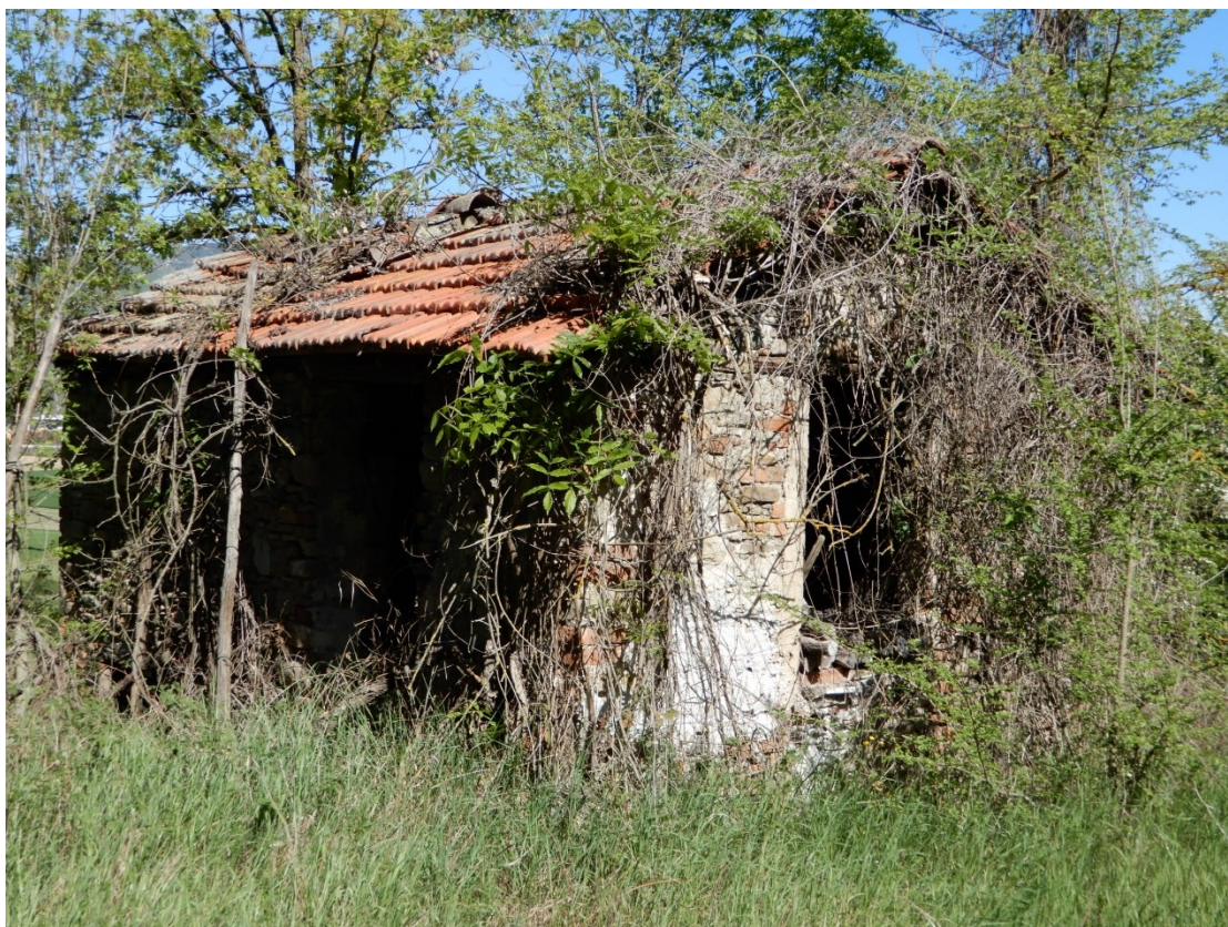
VISTA MAGAZZINO NEI PRESSI DELLA CASCINA
