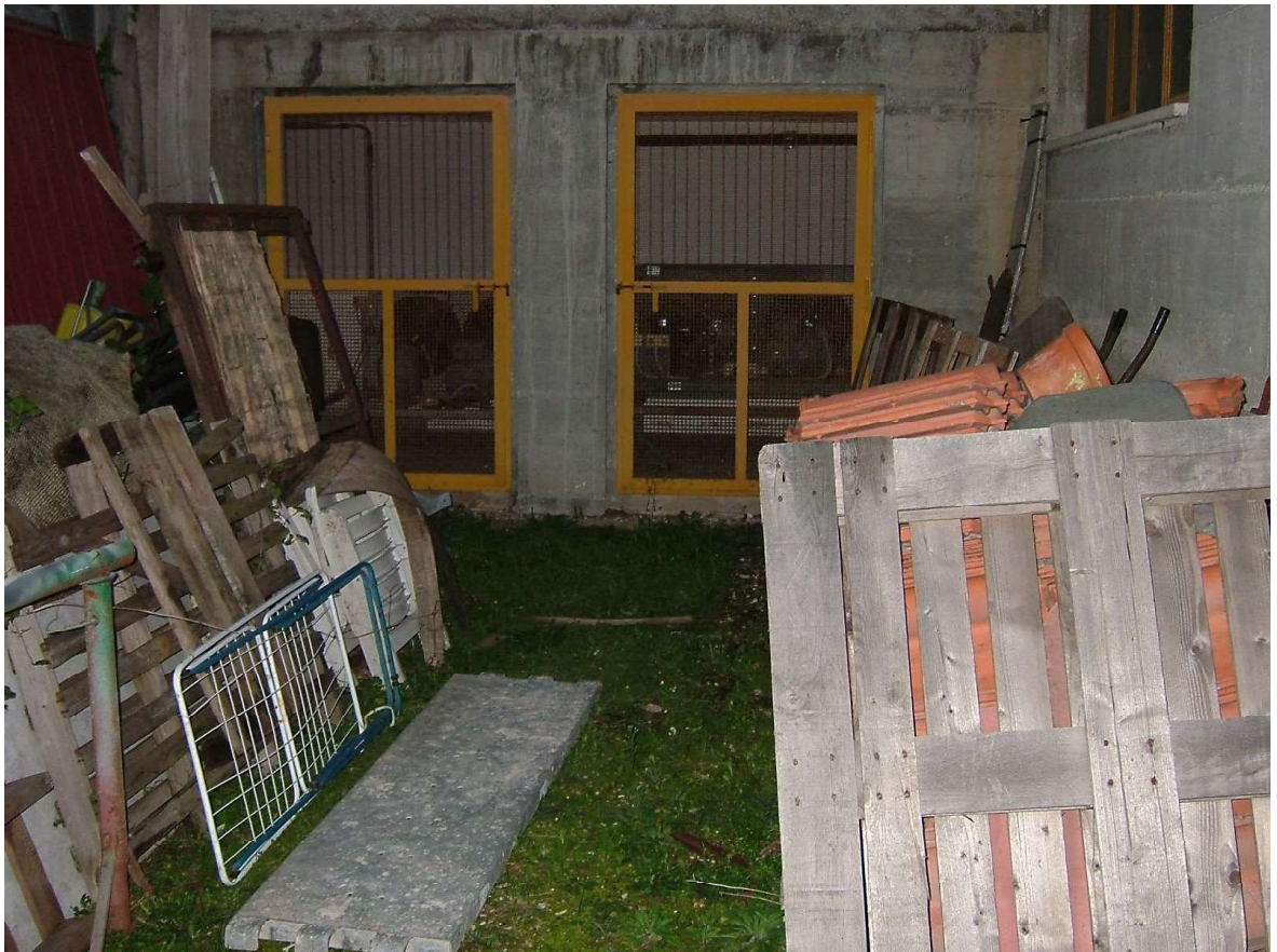
Foto 18 - area scoperta in fondo rampa di accesso al piano interrato
