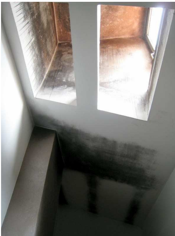
Foto n. 7. L'abbaino che porta luce al corridoio dalla copertura.
