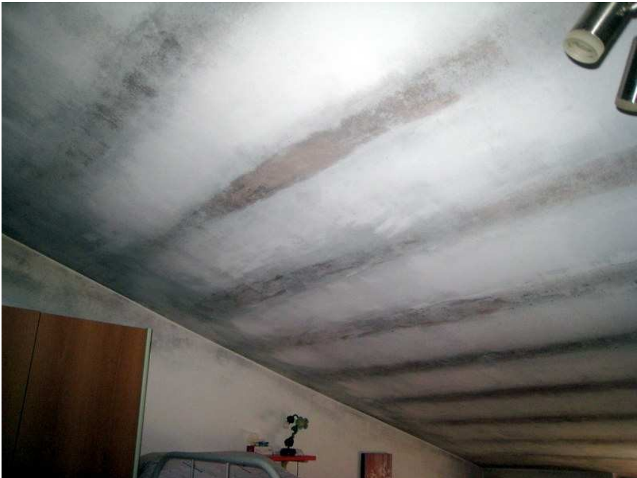
Foto n. 20-21-22. La cameretta è nelle medesime condizioni delle altre stanze. La muffa si è attaccata ai travetti del solaio segnandoli uno per uno secondo la cadenza di posa.
