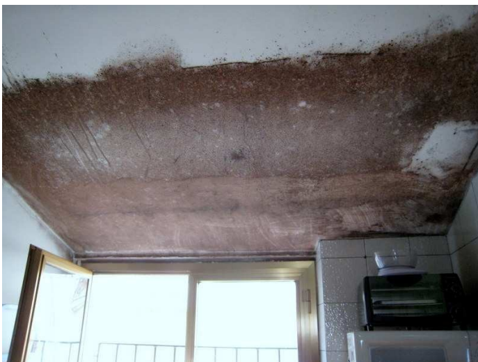
Foto n. 12-13. Dettagli della muffa da condensa presente in ciascuno dei travetti che formano il solaio di copertura. Il fenomeno è diffusissimo ed è pericoloso per la salute di chi vi abita.
