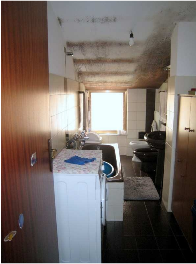
Foto n. 17-18-19. Il w.c. bagno presenta il tetto quasi totalmente intriso di muffa da condensa.
